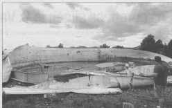
INSERVIBLE. Estado en el que quedó la balsa de Torres Torres tras el espectacular revienta de ayer
