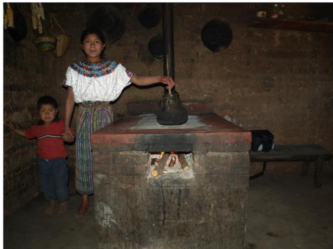
Figura 7.1.1.2.: Modelo de estufa de Santa María, Chiquimula. Se observa el horno cerrado y la plancha elevada
