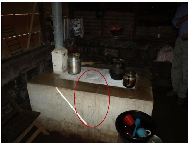
Figura 7.1.3.1.: Grietas en el concreto de las estufas
