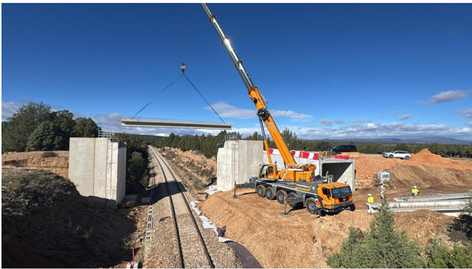
Control final de elementos estructurales y geometría ejecutada.
