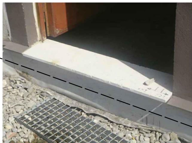
IMAGEN 2 CANALETA DE EMERGENCIA INTEGRADA EN FALDÓN: ESTADO ACTUAL
