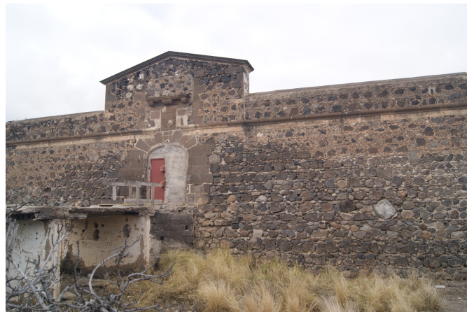
Imagen 1. Fotografía del alzado este. Elaboración propia.
