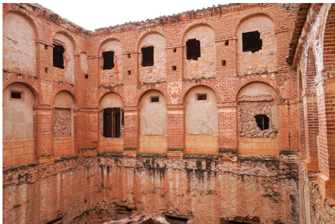
Imagen 5. Vista interior del claustro del convento de Liétor y agramilados simulando el ladrillo visto de manera ordenada.
