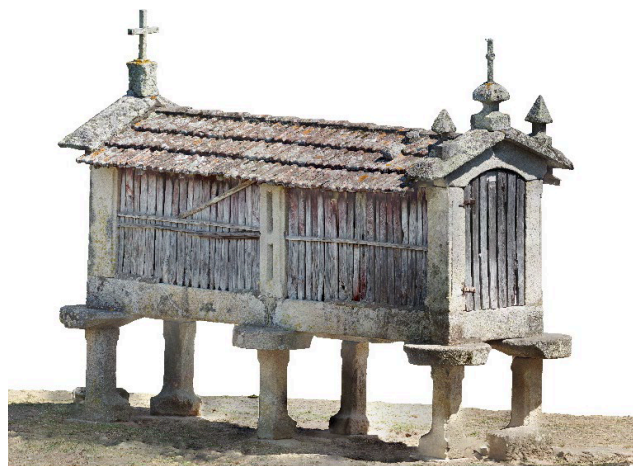
Fig. 1. Vista axonométrica del modelo 3D realizado con fotogrametría del canastro da Barroca. Estado actual. (Fuente: elaboración propia).
