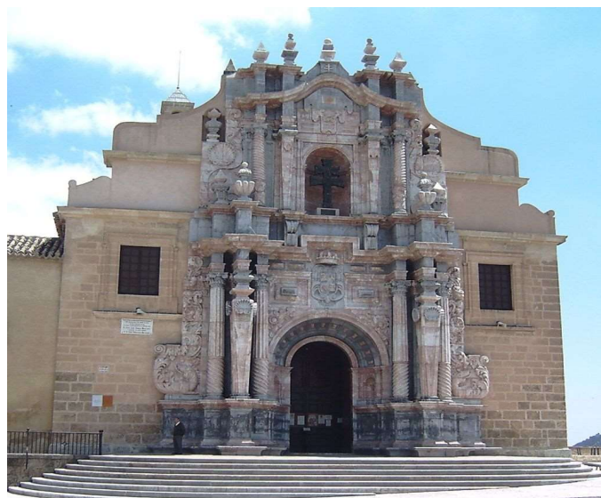
Imagen 2. Portada de la Basílica-Santuario de la Vera Cruz antes de las obras de restauración.
