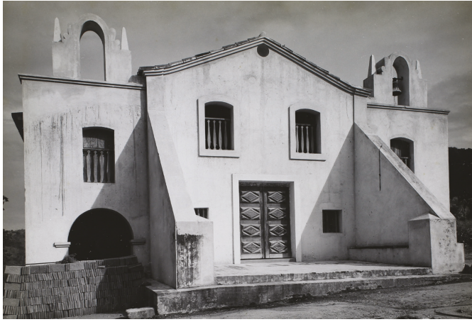
Figura 2: Fachada principal y nave del Mosteiro de São Francisco en 1955. Colección IPHAN, 1955.
