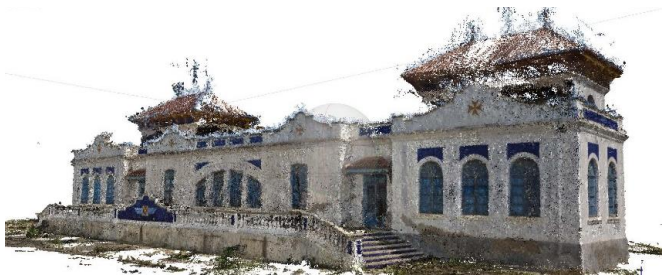
Imagen 7. Fotogrametría del Hospital-Botiquín, visual nube de puntos densa
