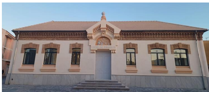
Imagen 7. Fachada principal de Museo Minero tras trabajos de rehabilitación
