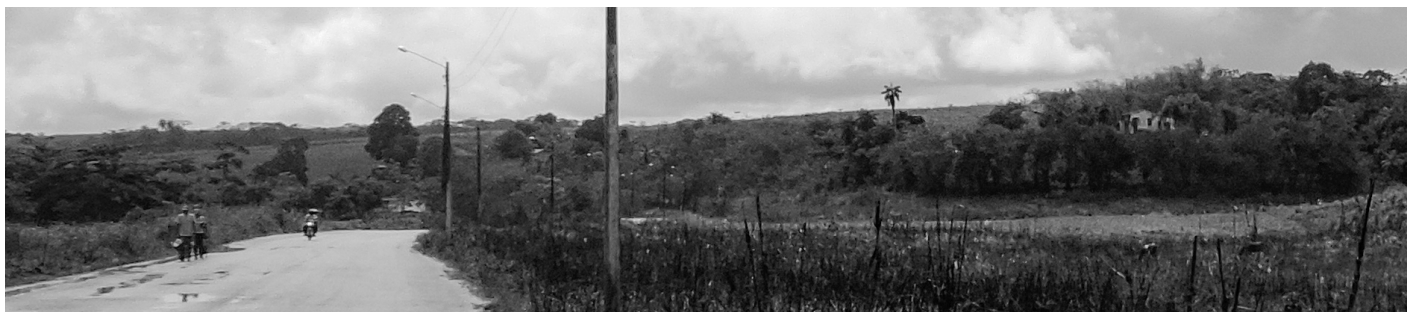
Figura 11: La carretera de São Severino bordea el Mosteirinho de São Francisco, situado en lo alto de la colina entre los árboles. Tomado por el autor, 2020.
