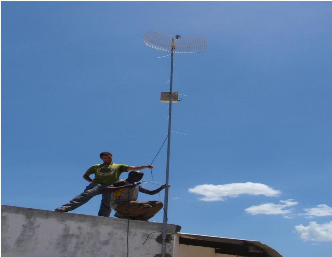
**Figura 5.14.** Fijación de las antenas a los mástiles.
