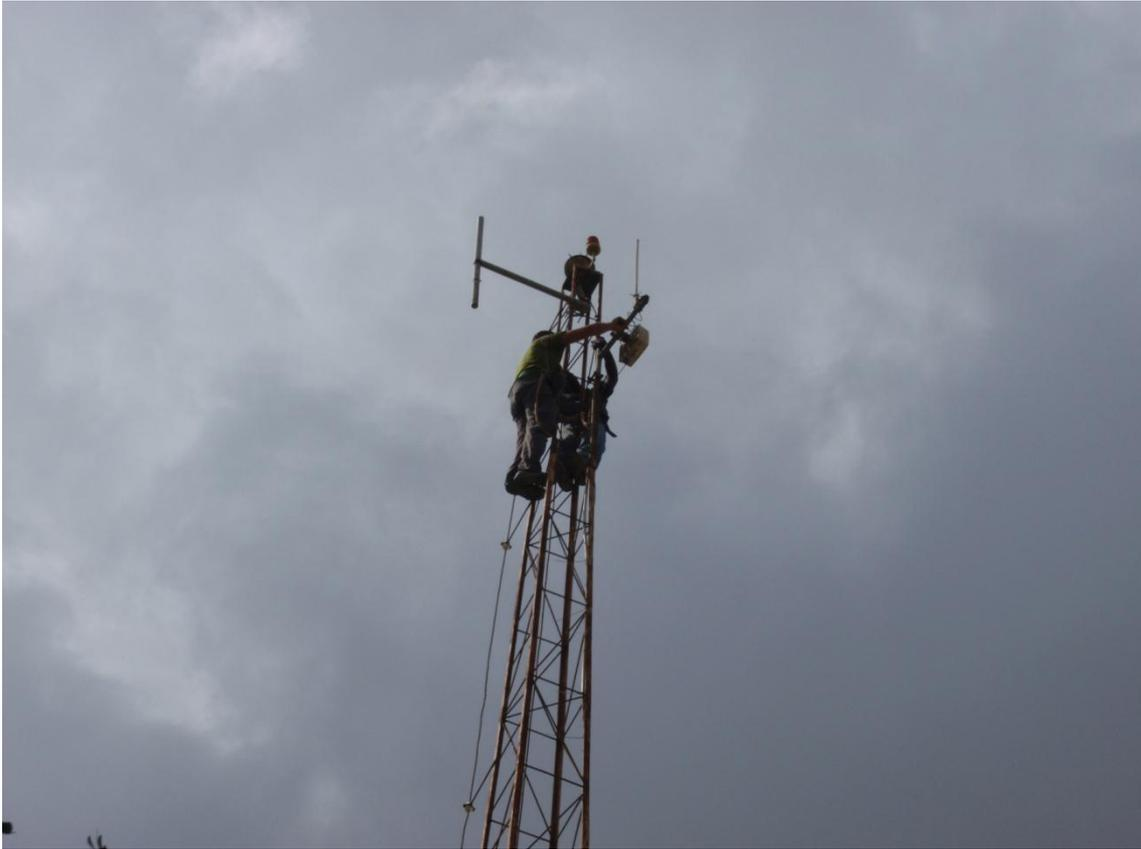
**Figura 5.11.** Recolocación de la tarjeta inalámbrica en San Juan Bautista.
