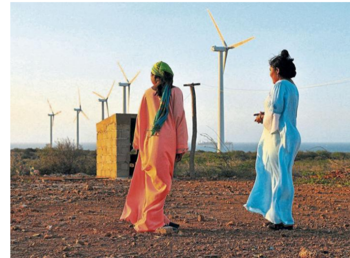
Imagen 2. El parques eólico Jepirachi. Archivo de Portafolio https://www.portafolio.co/economia/infraestructura/upme-concesionara-primera-linea-de-generacion-eolica-508739
