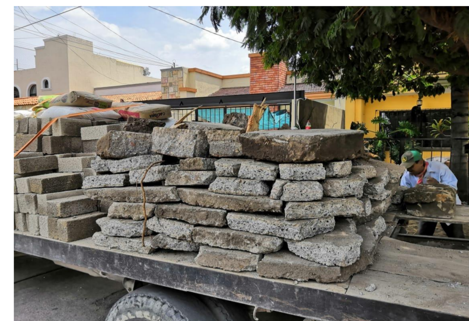
Imagen 4. Separación de Residuos del concreto. Autoría propia / Image 4. Concrete waste segregation. Own Authorship.
