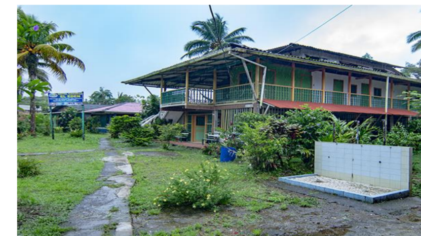
Fig. 6. Vivienda transición rural (Bahía Málaga – Valle).
