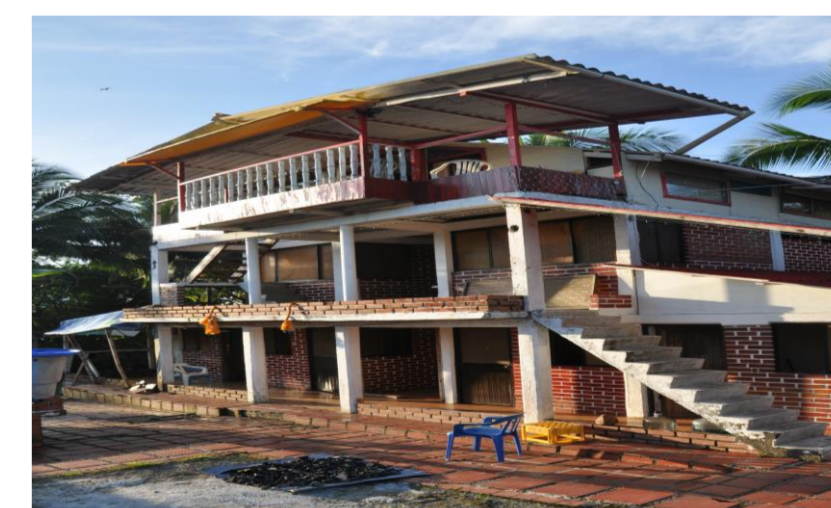
Fig. 7. Vivienda moderna urbana. (Bahía Málaga- Valle)
