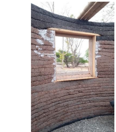
Figura 5 hiperadobe y cerramientos Figure 5 Hyperadobe and enclosures
