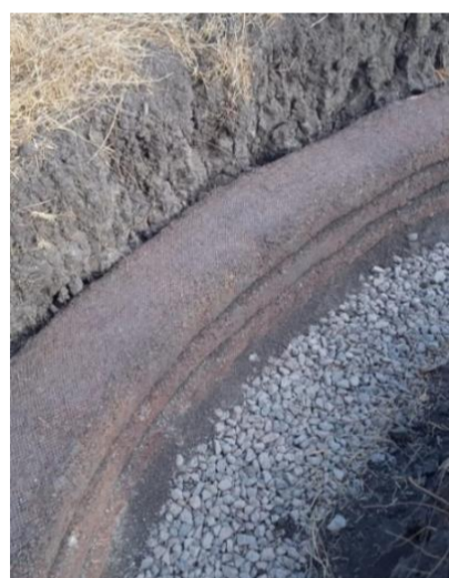
Figura 1: cimentación. Figure 1: Foundation.
