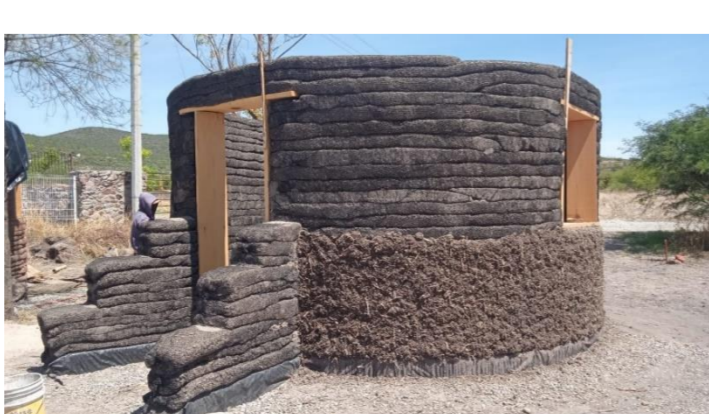
Figura 6 hiperadobe y revestimiento en la edificación. Figure 6 hyperadobe and lining in the building.
