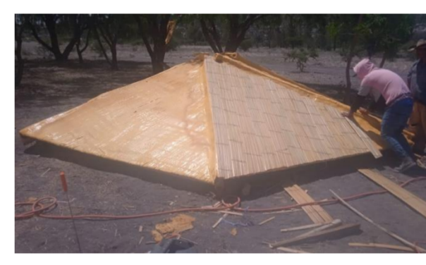
Figura 8 aplicación de poliuretano en cubierta. Figure 8 Application of polyurethane on deck.
