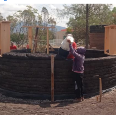
Figura 3. Extendido de material con malla. Figure 3. Extended material with mesh.
