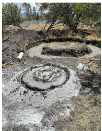
Figura 2: mezcla para cimentación. Figure 2: Foundation mixture.
