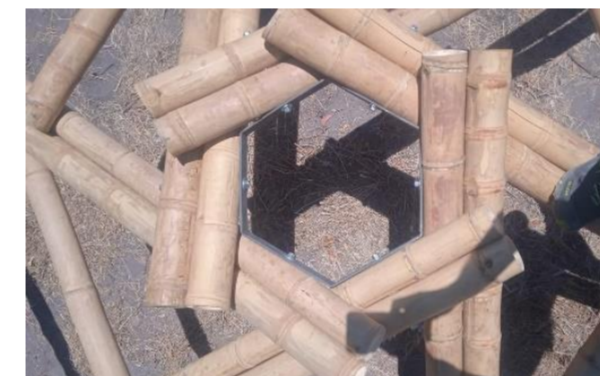
Figura 7 estructura para cubierta segunda etapa Figure 7 Structure for Second Stage Cover
