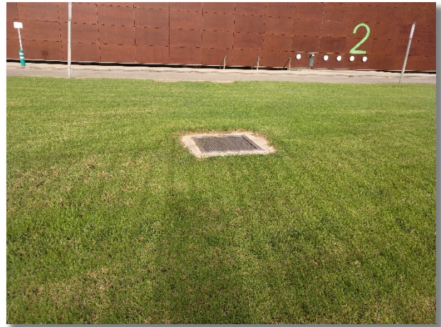
Foto 16. Rejilla de ventilaci3n existente en la zona del CPI
