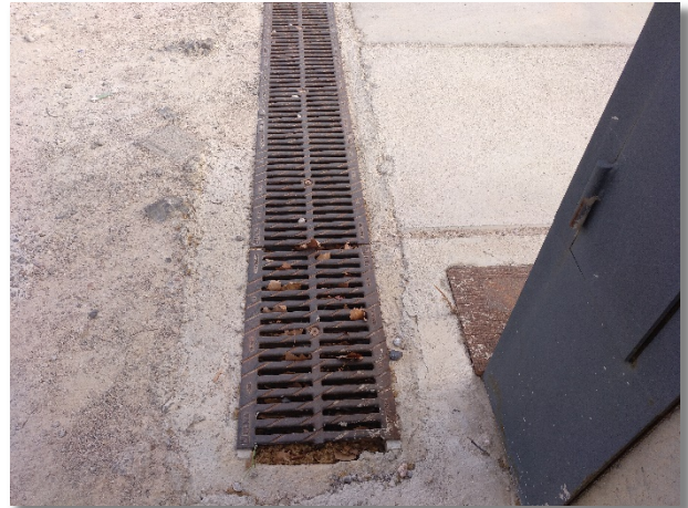
Foto 14. Canal de drenaje existente a la entrada al recinto de la UPV
