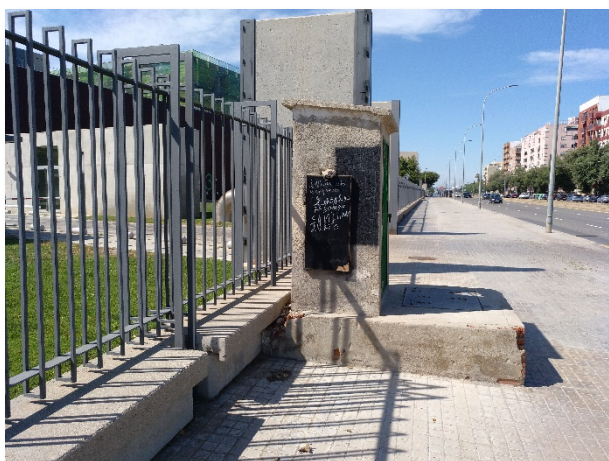
Foto 20. Construcci3n exterior a la UPV que alberga la compuerta de regulaci3n de la acequia
