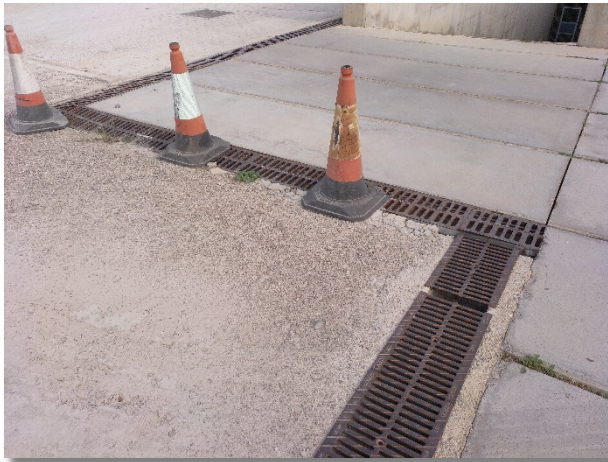
Foto 15. Canal de drenaje existente
