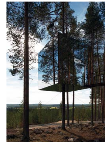
Cabaña del Treehotel . Tham & Videgård Arkitekter 2010. Imagen: Åke E:son Lindman, Lindman Photography.
