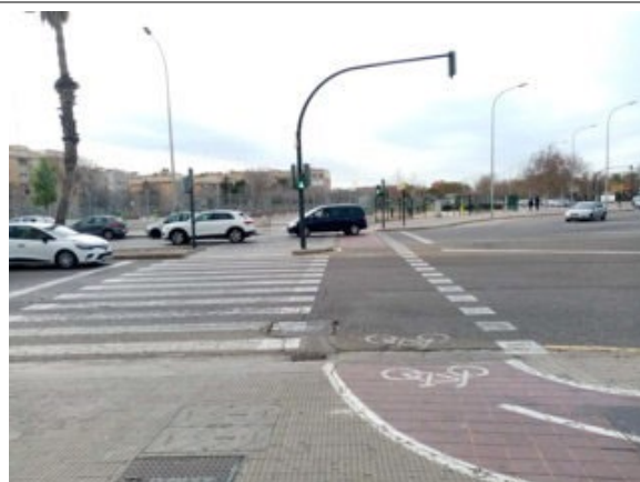
Paso de peatones nº 10. Conexión de las aceras a ambos lados de la C. Lluís Peixó forma continua.
