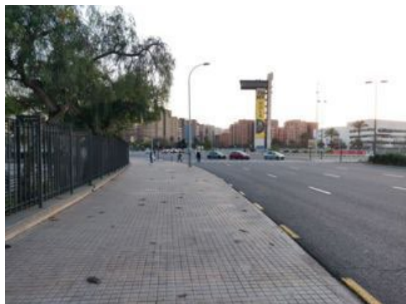
Inicio de aceras en Camí de Vera
