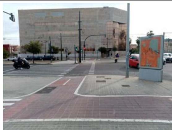
Paso de peatones (nº 11). Paso de peatones en tres tramos que cruzan la calzada y la vía del tranvía, regulación semafórica. Señalización horizontal adecuada en todos los tramos. Sin embargo, isleta intermedia sin protección para los peatones que esperan. Conexión continua de las aceras a ambos lados de la Av. de los Naranjos (en rotonda).
