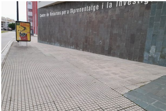
Al este del acceso B en Carretera Sèquia del Rei
