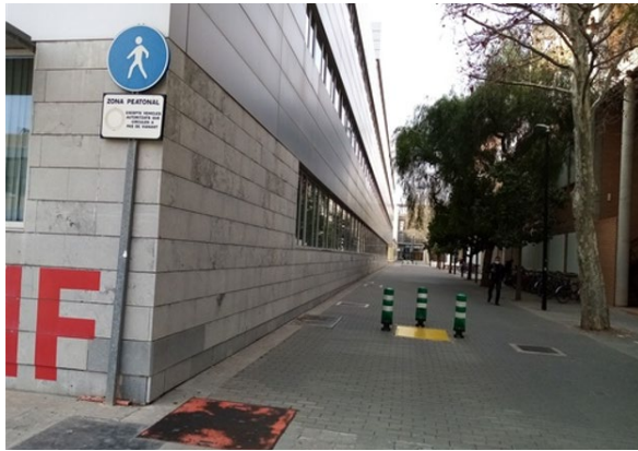
Acera ancha, pero con obstáculo en su parte central. Señal vertical indicando que se trata de zona peatonal.
