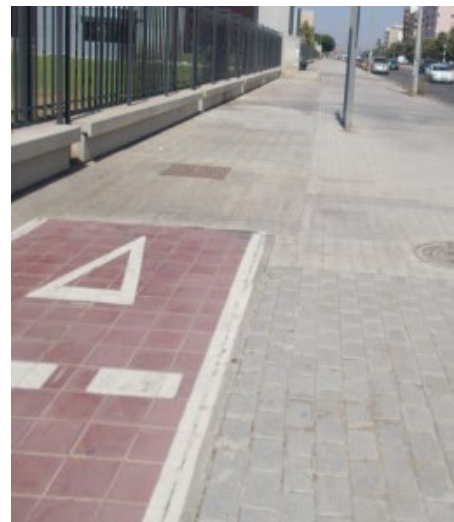
Interrupción del carril-bici procedente de Av. de los Naranjos en C/Ing. Fausto Elio
