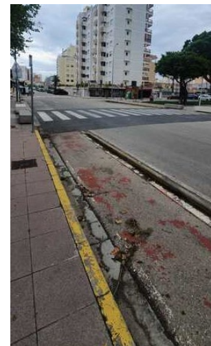
3 - Final de tramo 3 y enlace con tramo que discurre por P.º Rosa de los Vientos
