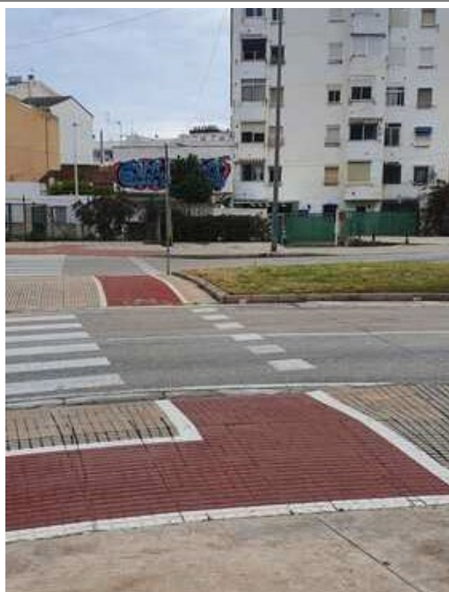
Carril bici segregado en el cruce con la calzada, paralelo al paso de peatones
