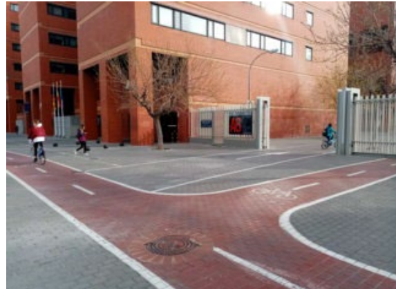
Tramo frente a Facultad de Derecho (UV). Carril con pintura claramente visible, bidireccional, sin seto u otras plantas en sus laterales
