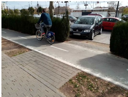
Acceso R: carril poco visible, con pintura muy deteriorada. Señalización en el cruce muy deteriorada. Barrera vegetal a ambos lados del carril desde el acceso R en dirección a la rotonda de la Av. de Cataluña. Acceso a plazas de aparcamiento cada 25 metros aproximadamente.
