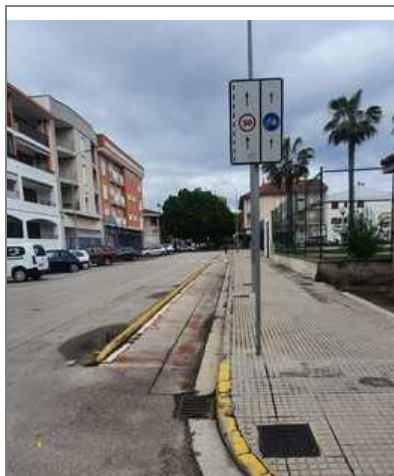
1 - Señal vertical que indica el carril bici segregado en la calzada
