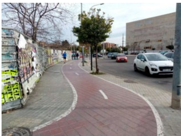
Estrechez de zona peatonal por ocupación del carril-bici en la acera de la rotonda
