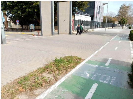
Acceso R: carril poco visible, con pintura muy deteriorada. Señalización en el cruce muy deteriorada. Barrera vegetal a ambos lados del carril desde el acceso R en dirección a la rotonda de la Av. de Cataluña. Acceso a plazas de aparcamiento cada 25 metros aproximadamente.
