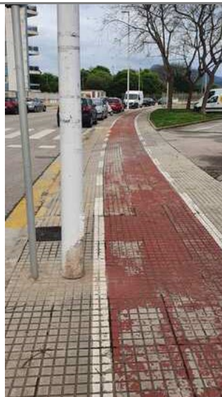
Intersección con aparcamiento sin señalizar la prioridad/peligro. Espacio para el peatón inexistente
