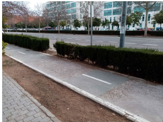
Acceso P: Carril-bici en las proximidades del acceso P (entre acceso P y acceso R). Pintura muy deteriorada
