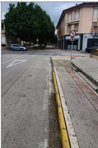
2 - Interrupción del carril bici en el cruce con c/Cullera.
