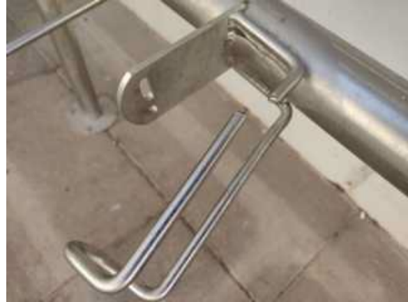
Aparc. patinetes nº 12: Corte de cierre con cizalla
