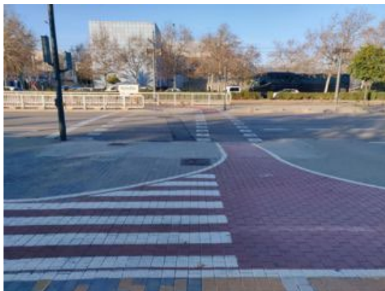
Paso ciclista habilitado junto al paso de peatones
