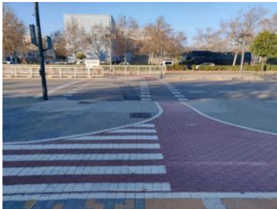
Conexión con el carril-bici existente al otro lado de la Avda de los Naranjos, junto a la Universidad de Valencia. Carril delimitado, con pintura fácilmente visible y señalización horizontal en el cruce con peatones.
