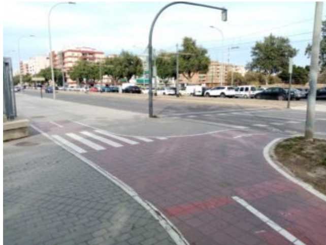
Tramo de carril-bici en el cruce c/ Ing. Fausto Elio – Av. de los Naranjos
