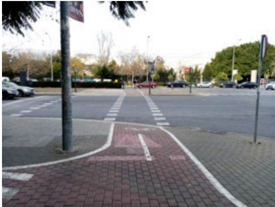
Cruces de carril-bici junto a paso de peatones, segregado y señalizado (lado sur junto a UV)
