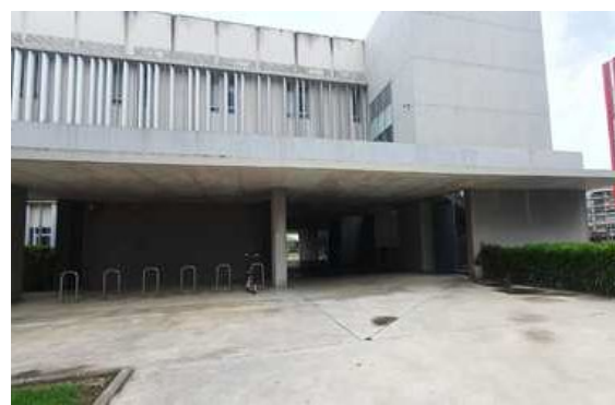
Acceso a edificio H desde parking en superficie
