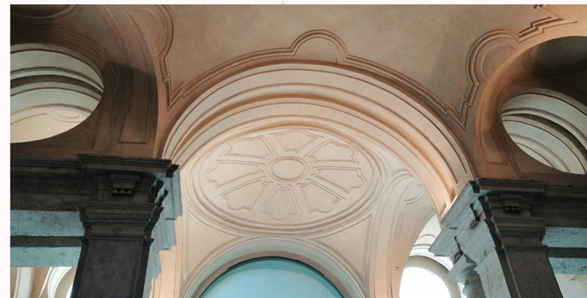
Fig. 2. Sistema abovedado del atrio del Palazzo Mazzonis (Foto de F. Ronco).
