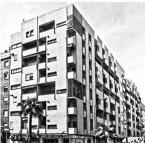
*Grupo Residencial Virgen de los Llanos* Otegui Tellería, Sanchis Pérez, Soler Verdú y Vidal Vidal. 1972
