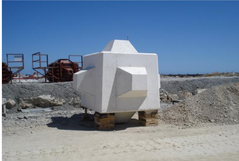
*Figura 4. Cubípodo fabricado en Málaga.*
