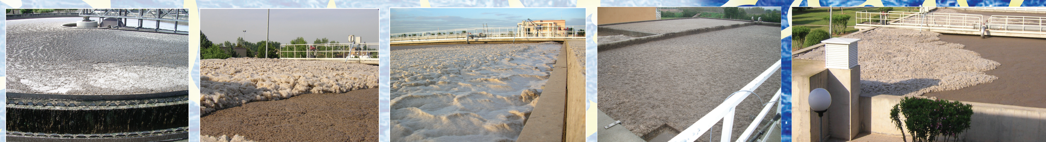
Fig. 1 - Espumas biológicas en el reactor biológico y decantador secundario.
