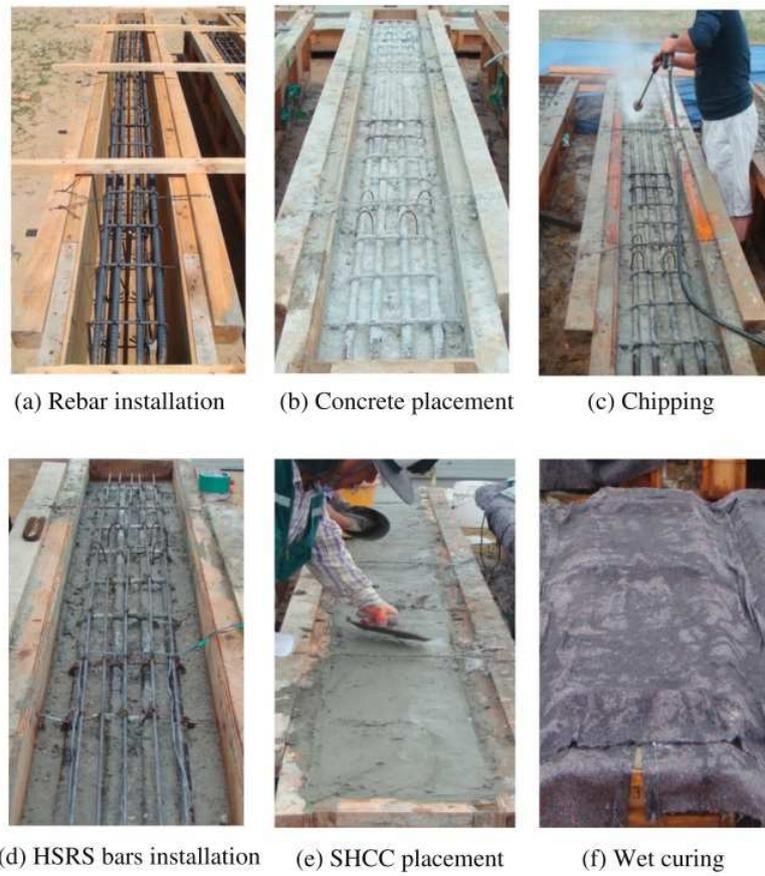
Figura 2.43: Proceso de fabricación. Fuente: Kim et al. 2014, [37]
