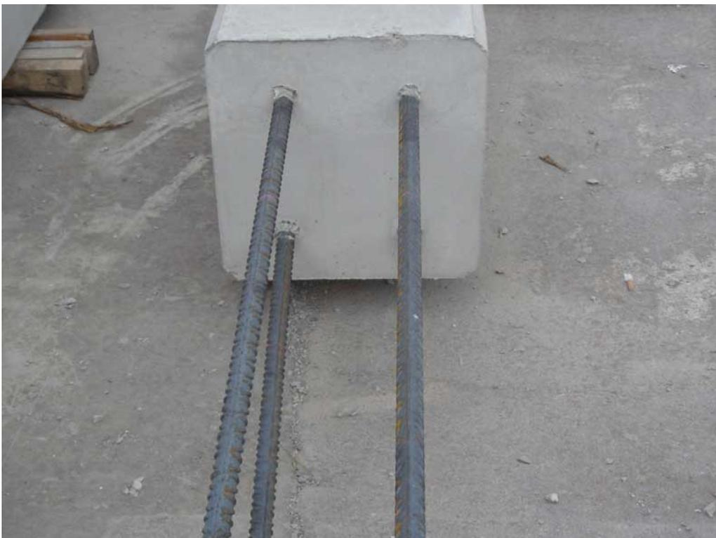
Figura 6.6: Ejemplo de pilar para unión con vainas.
