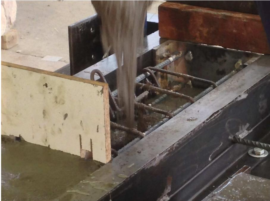
Figura 4.20: Vertido del hormigón de la amasada 2.
