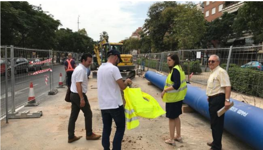
Imagen de archivo de la intalación de nueva tubería en Jacinto Benavente AYUNTAMIENTO -
