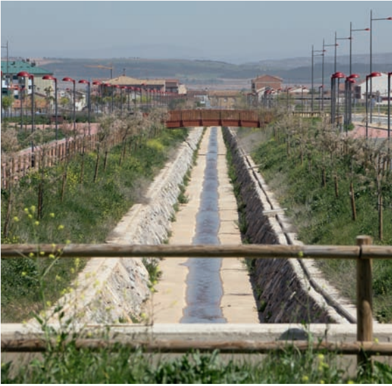
FIGURA 26. SISTEMA DE RECUPERACIÓN DE AGUA DE LLUVIA EN POLÍGONOS INDUSTRIALES
