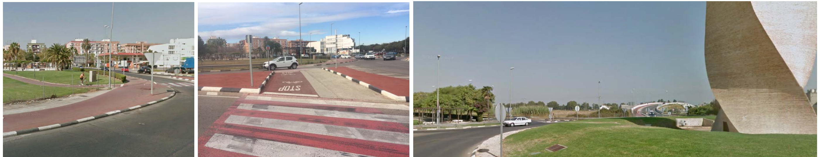
De izquierda a derecha: Conexión del carril bici existente procedente del parque de Alaquas (Parc del Dijous) colindante con la CV-407 y rotonda con la CV-403, paso actual mediante puente con calzada con un carril pos sentido de circulación y con carril bici y peatones (al fondo).
