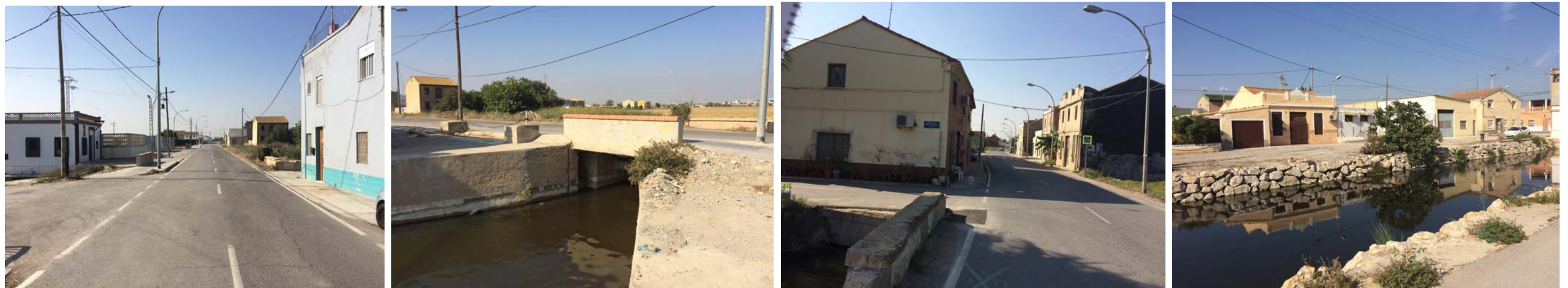
De izquierda a derecha: Camí del Tremolar desde la bajada de la pasarela, como se aprecia la sección se encuentra desordenada, dónde los usos peatonales no están definidos. El camino es atravesado por acequias de riego (Sèquia de l'Or) que estrecha la plataforma, por lo que se ampliará el paso sobre las mismas mediante placas prefabricadas. El embarcadero del Tremolar tiene un ancho medio superior a los 10 m.
