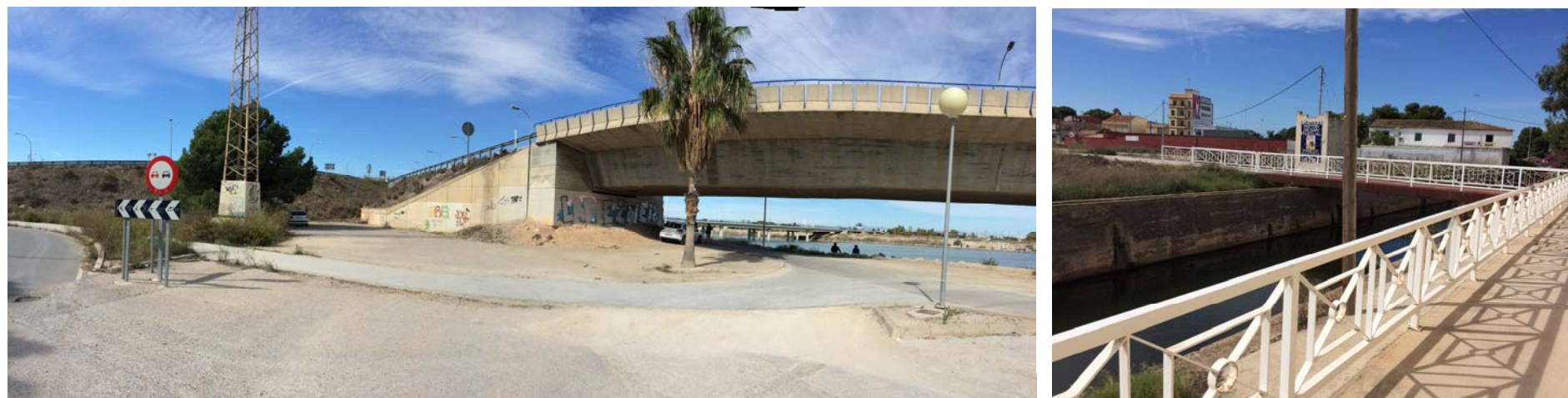
Conexión con Carril Bici de Valencia hacia el este y Sèquia del Canal.
