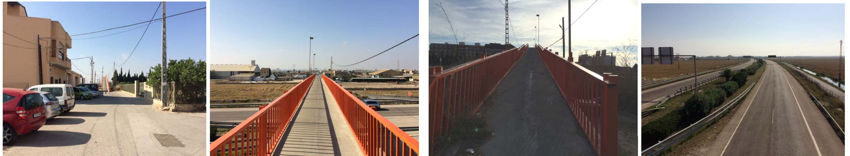
De izquierda a derecha: Camí del Tremolar en el casco de Pinedo, al fondo rampa de acceso pasarela. Tramos de pasarela sobre la CV-500 y rampa de bajada en sentido Camí del Tremolar (lado oeste).
