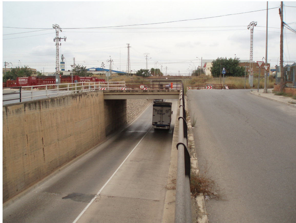
Calle Villa de Bilbao. Paso inferior a la línea de FGV y calle Islas Baleares.
