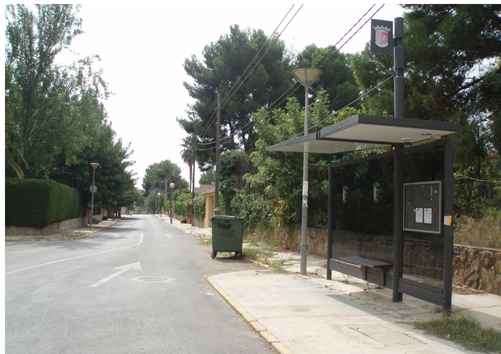
Aceras con ancho útil insuficiente y en mal estado de conservación
