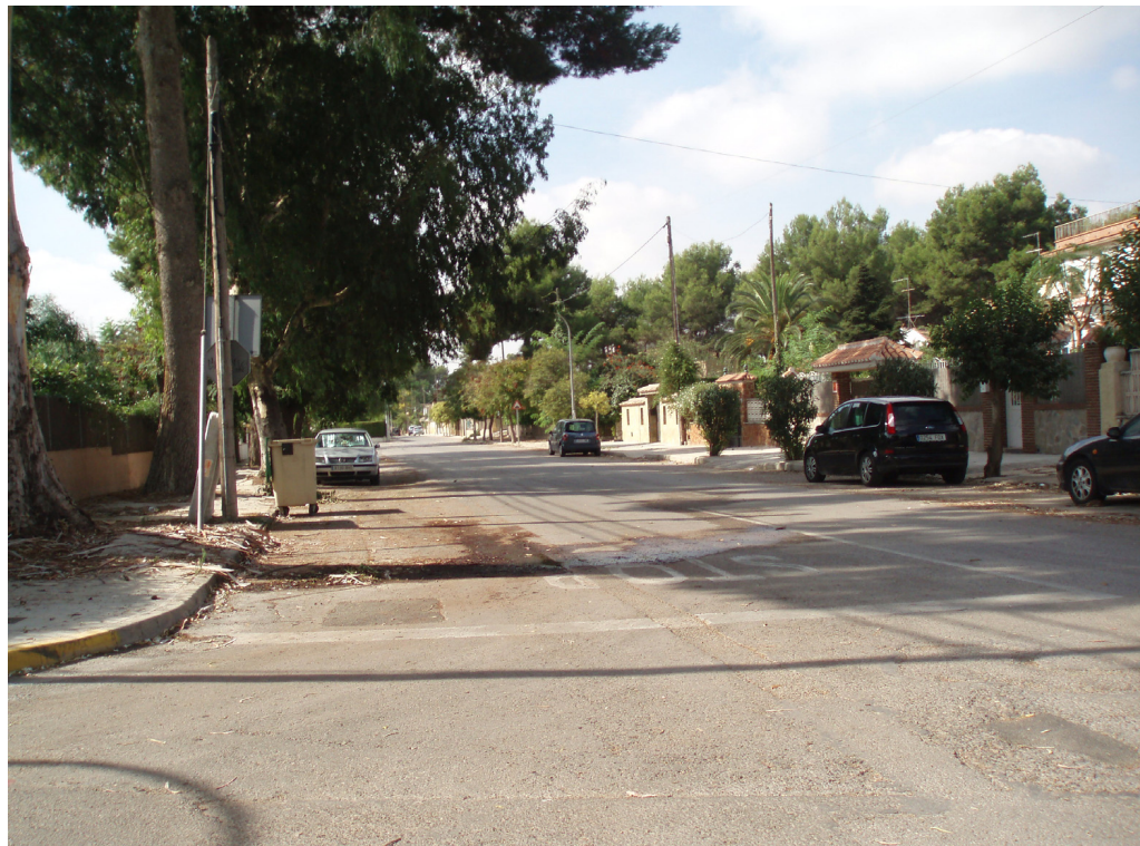
Aceras con ancho útil insuficiente y en mal estado de conservación
