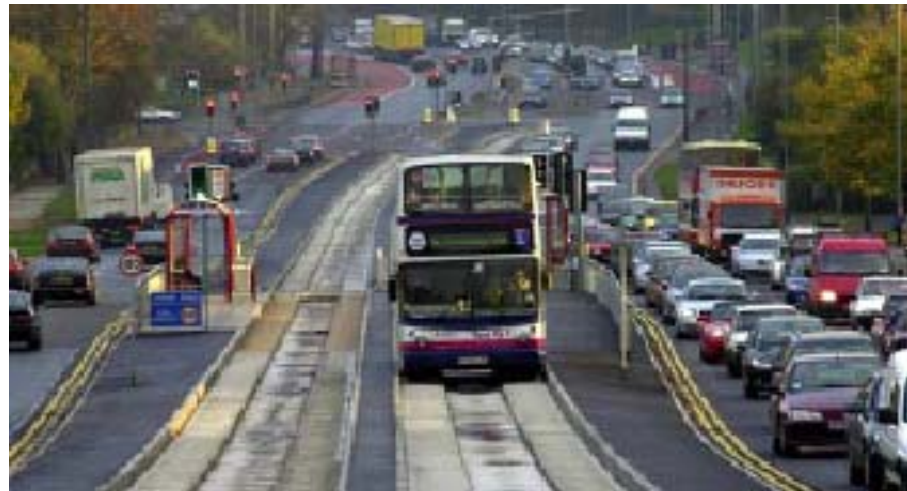
Calzada segregada de BTR de Leeds (Inglaterra)
