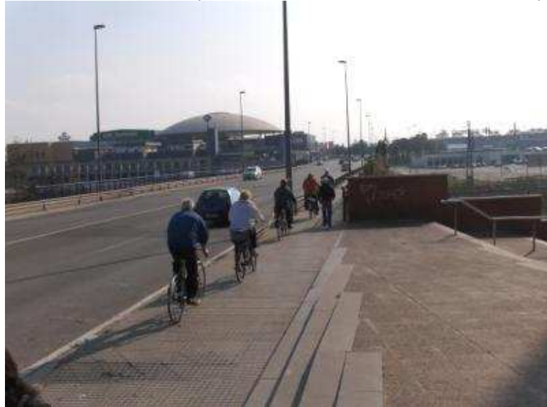
Ilustración 19 Acera en el puente de Av.Blasco Ibáñez sobre el Río Serpis.
