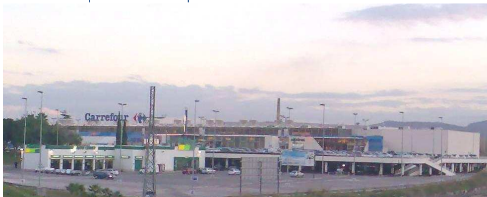
Ilustración 10 Aparcamiento en superficie en el Centro Comercial Carrefour
