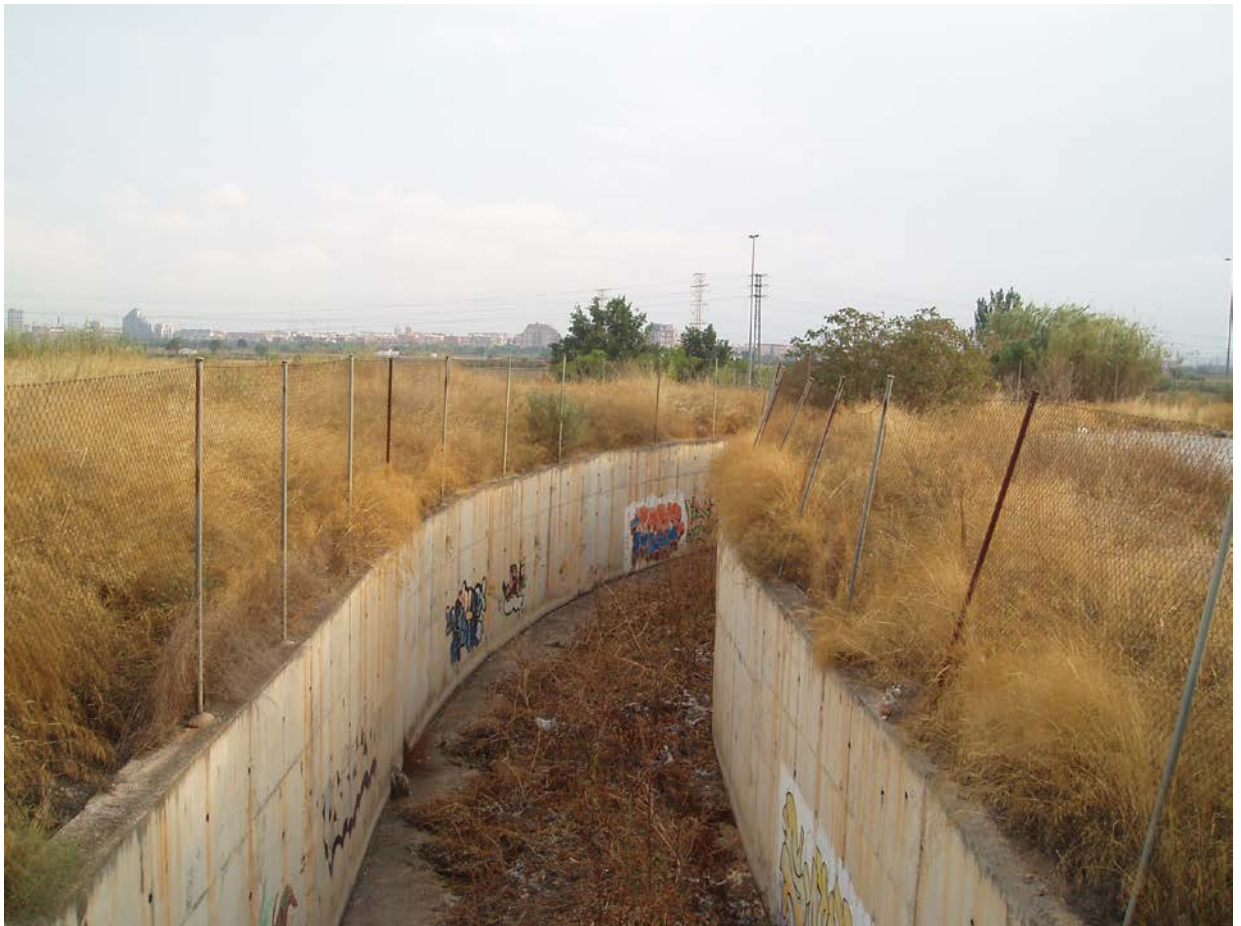
Figura 6.27 Encauzamiento del Barranco de Benimámet.
