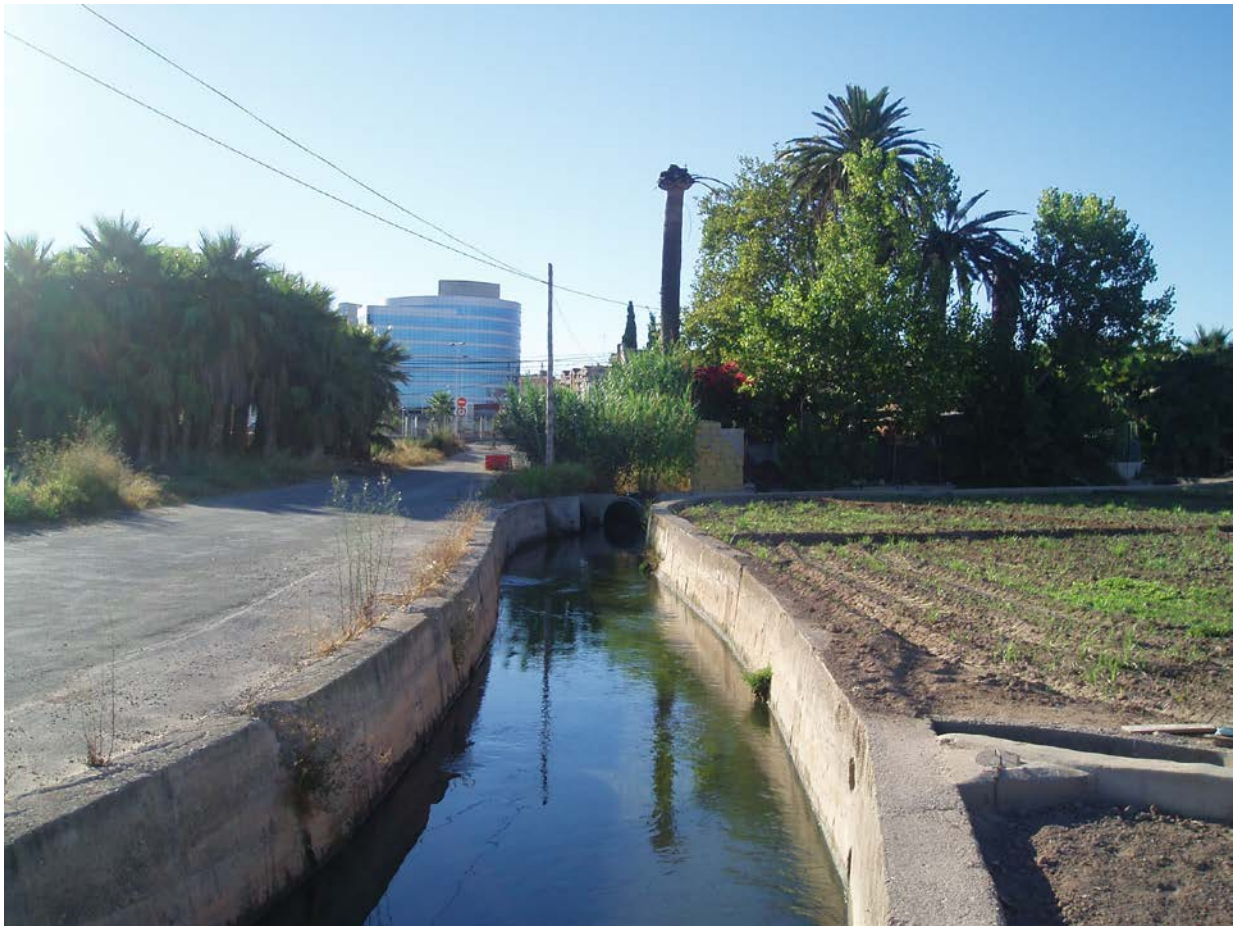
Figura 7.20 Zona inundable de la Acequia de Vera aguas arriba del FFCC de Barcelona.
