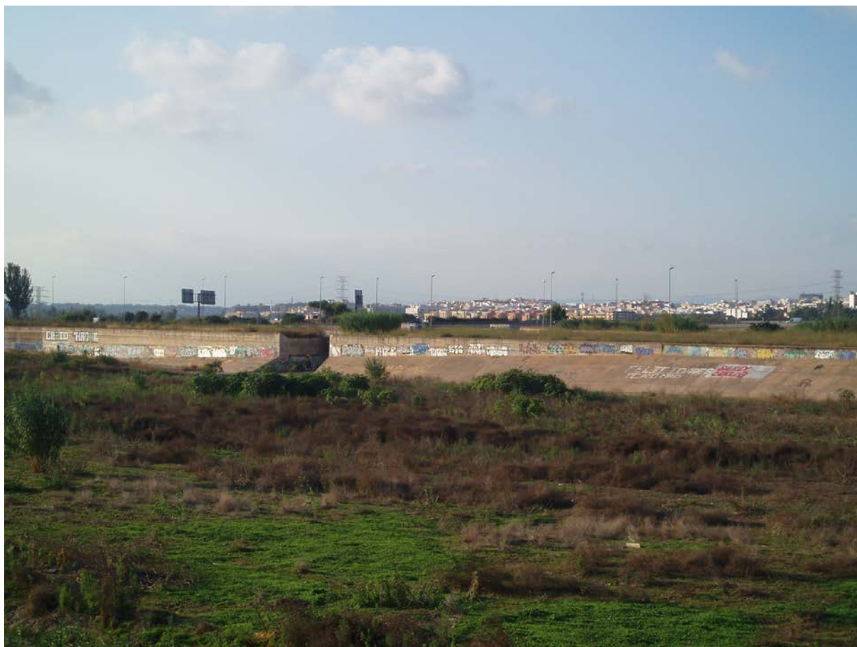
Figura 6.3 Cajero Izquierdo de la Solución Sur en la toma. Se aprecia la acometida del Barranco de En Dolça.
