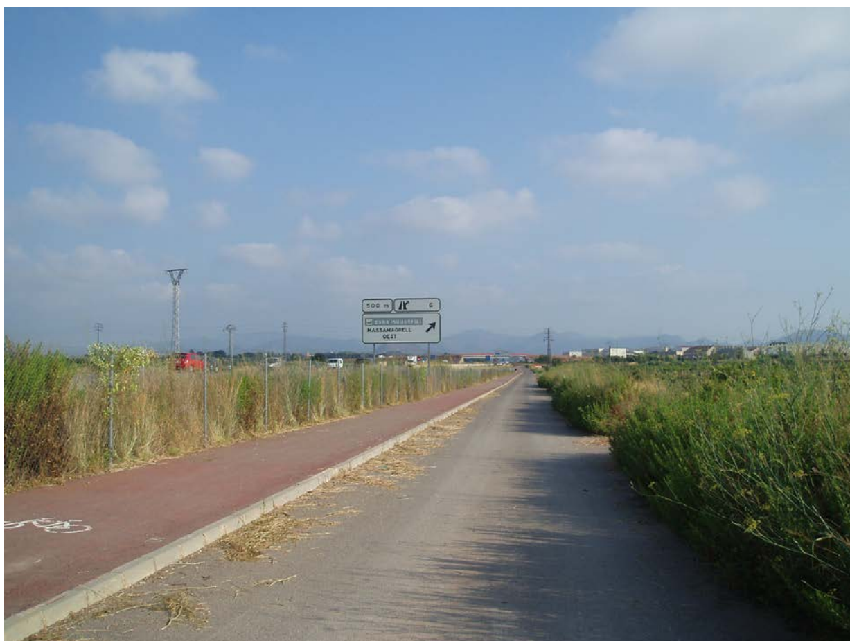
Figura 7.3 Autovía CV-32 Posee un terraplén superior a 2 m.
