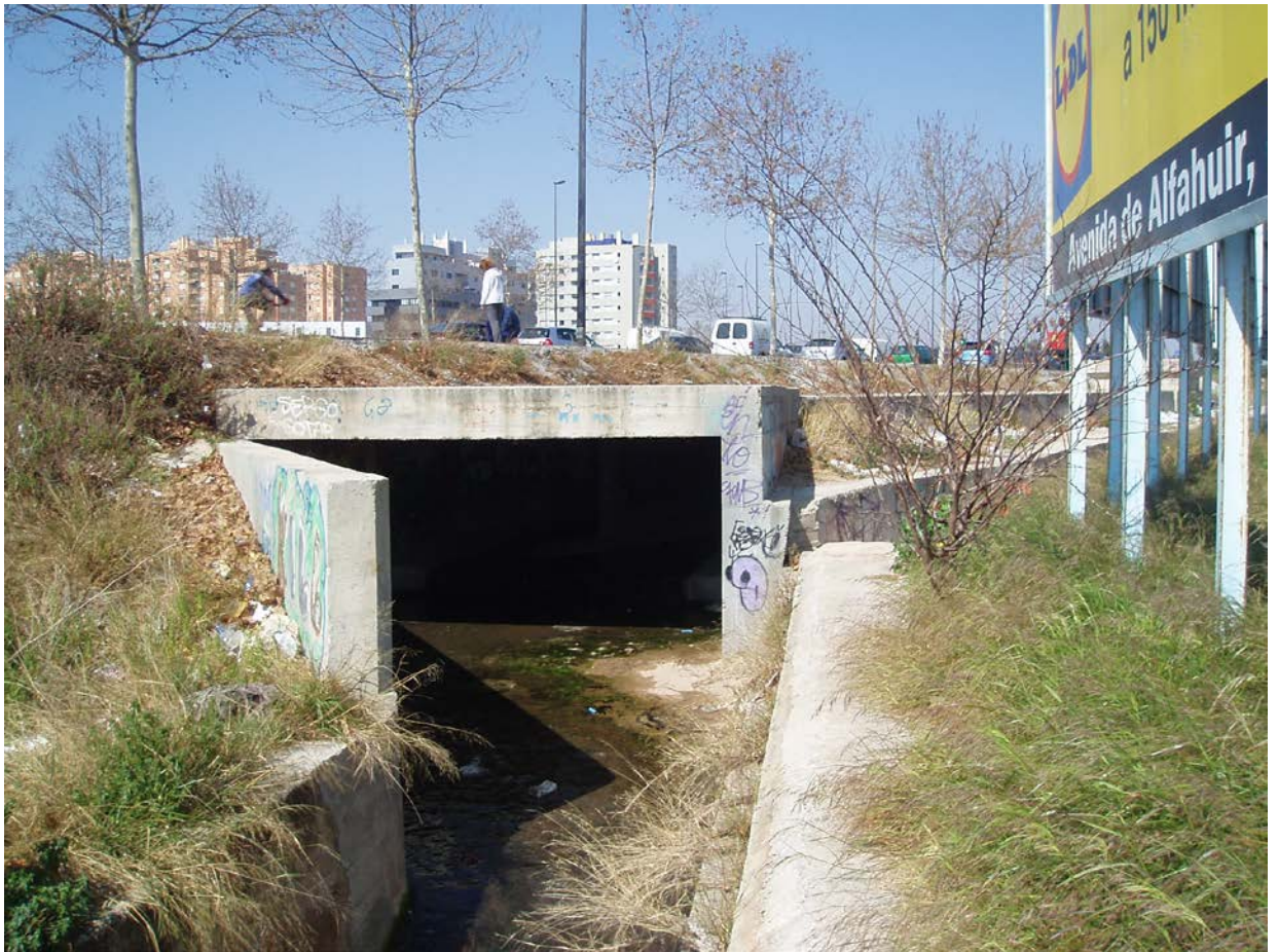
Figura 6.30 Aliviadero final del Colector de Hermanos Machado a la Acequia de Vera.
