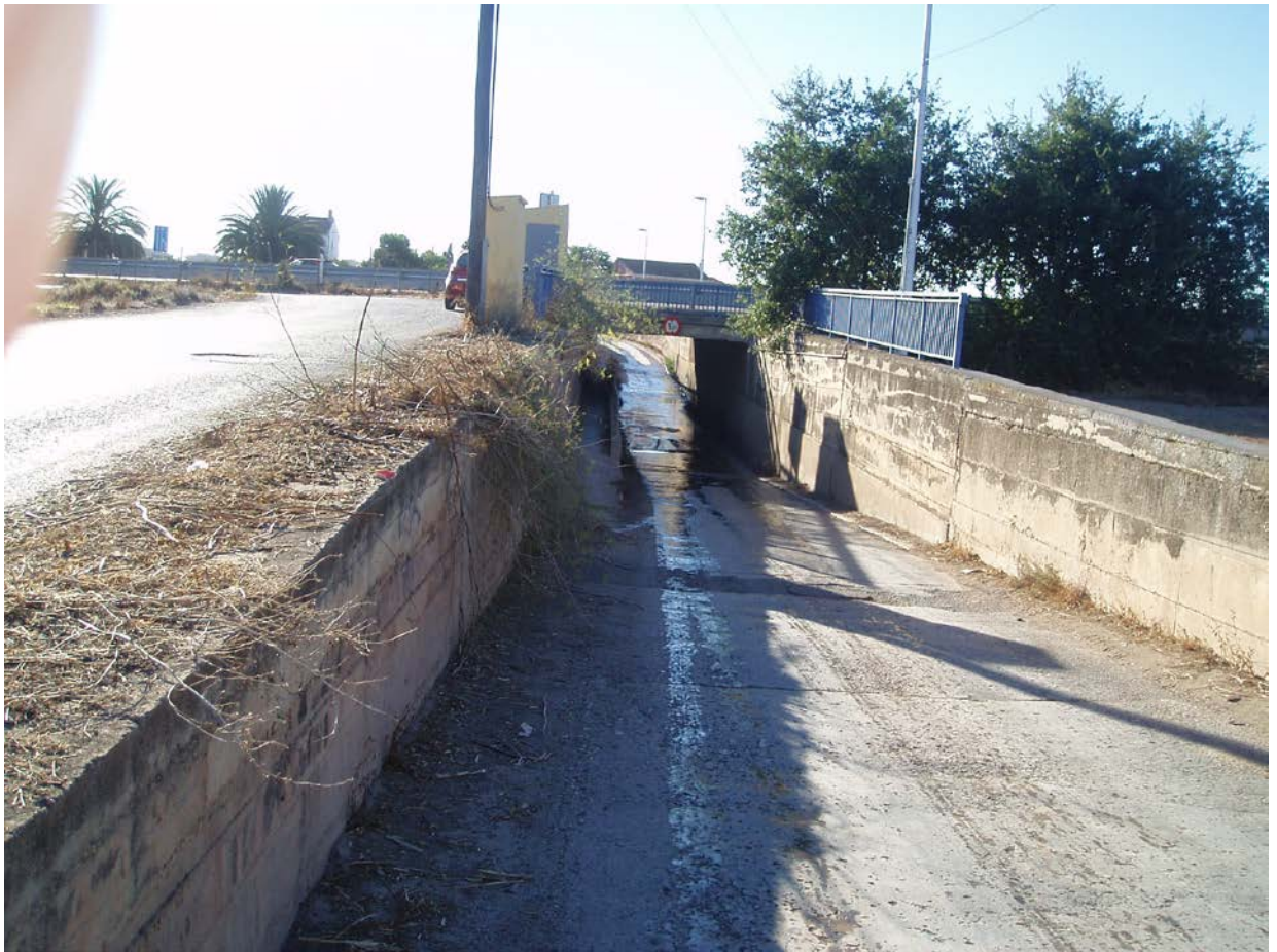
Figura 7.19 Paso inferior del camino de Farinós.
