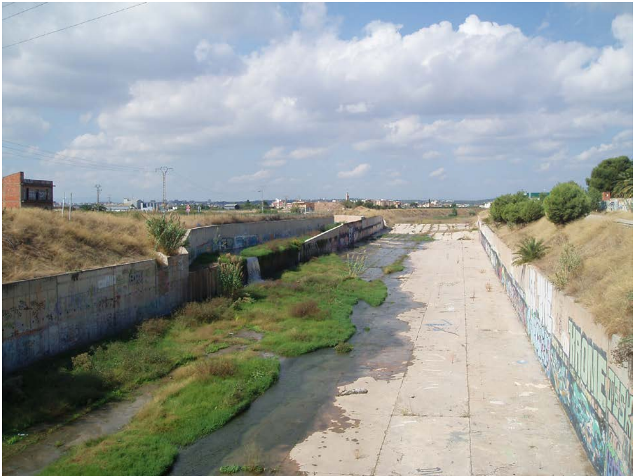
Figura 6.18 Encauzamiento del Barranco de Carraixet en Tavernes Blanques. Se observa la incorporación del Interceptor del Palmaret Medio.
