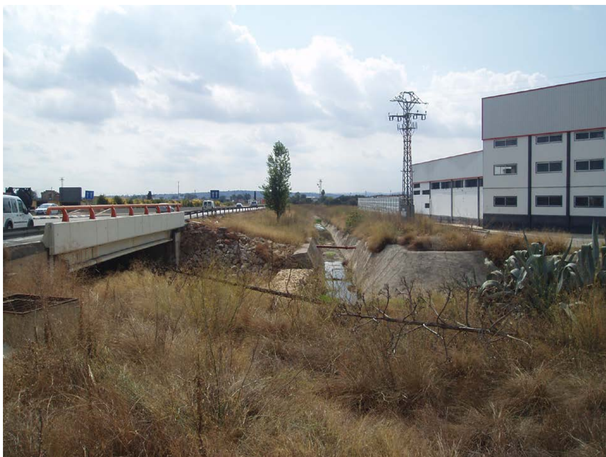
Figura 6.37 Interceptor de Aldaia.
