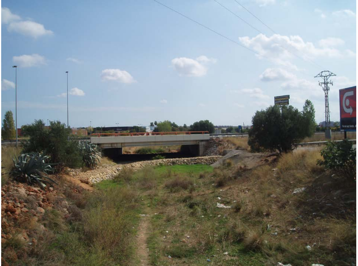
Figura 6.38 Toma del Interceptor de Aldaia en el barranco de La Saleta
