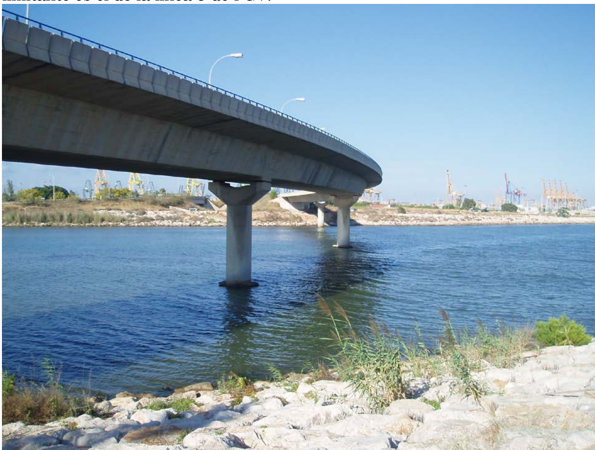
Figura 6.15 Puente del acceso al puerto en la desembocadura de la Solución Sur.
