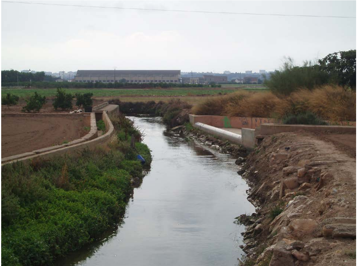
Figura 6.25 Aliviadero de la Acequia de Vera al Interceptor del Palmaret Medio.
