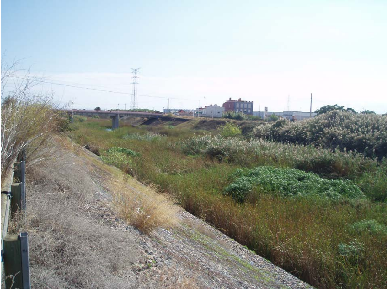
Figura 6.17 Encauzamiento del Barranco de Carraixet en Alboraià.
