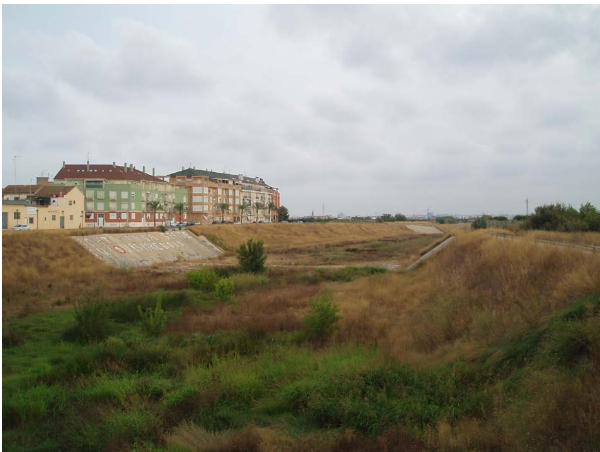
Figura 6.20 Encauzamiento del Carraixet Tramo 2 frente a Vinalesa.
