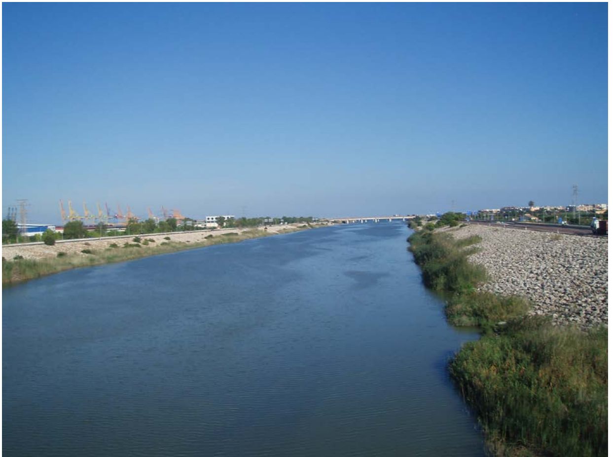
Figura 6.11 Tramo 3 de la Solución Sur. Vista hacia aguas abajo desde el puente de la Carrera de En Corts.
