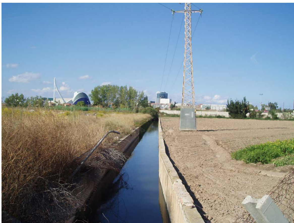
Figura 7.27 Zona inundable a lo largo de la Acequia del Cano de la Molinera
