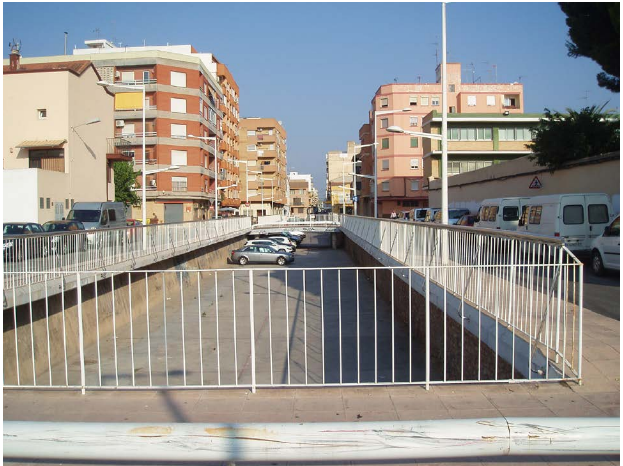
Figura 7.6 Tramo encauzado en el casco antiguo de Massamagrell.
