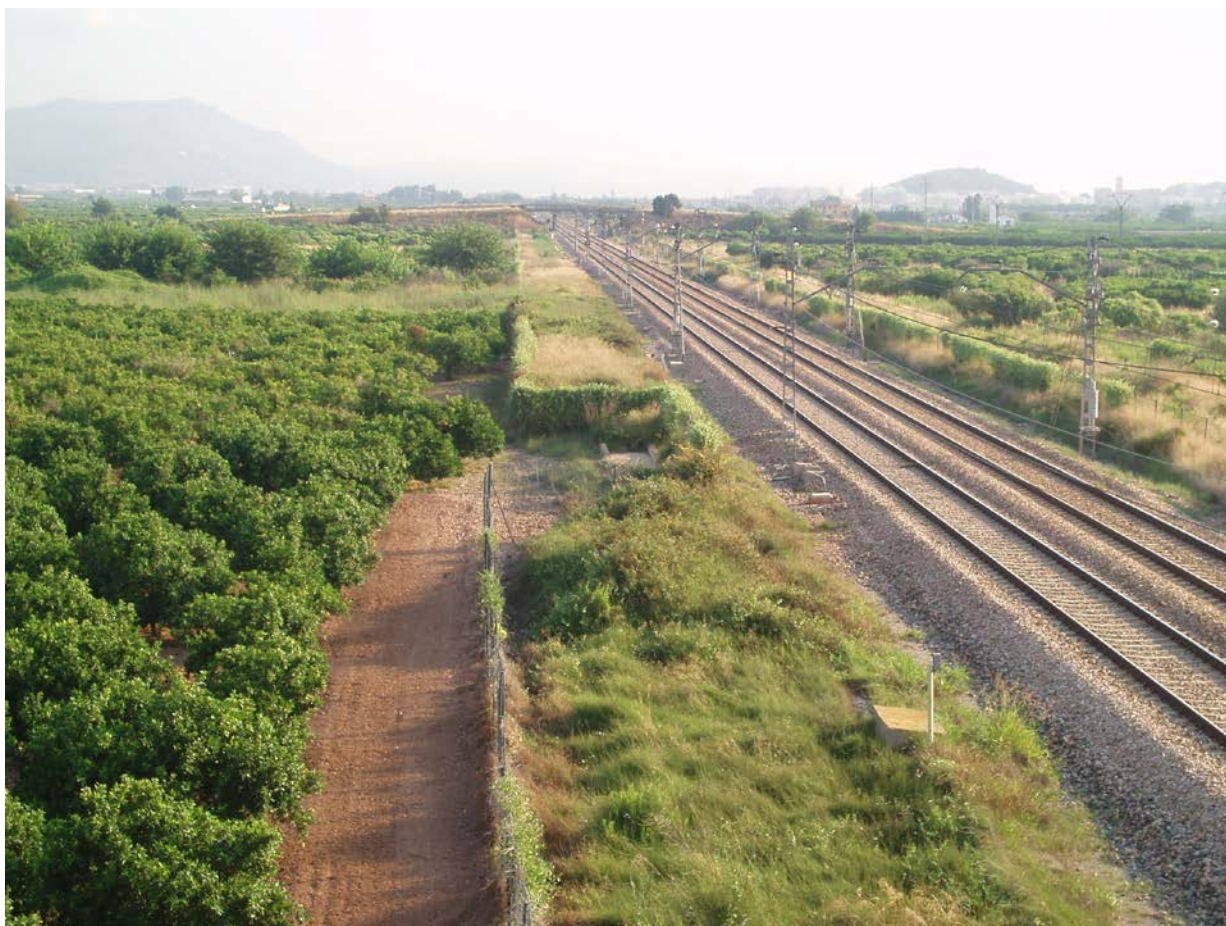
Figura 7.7 Terraplén del ferrocarril Valencia – Barcelona en Rafalell y Vistabella.
