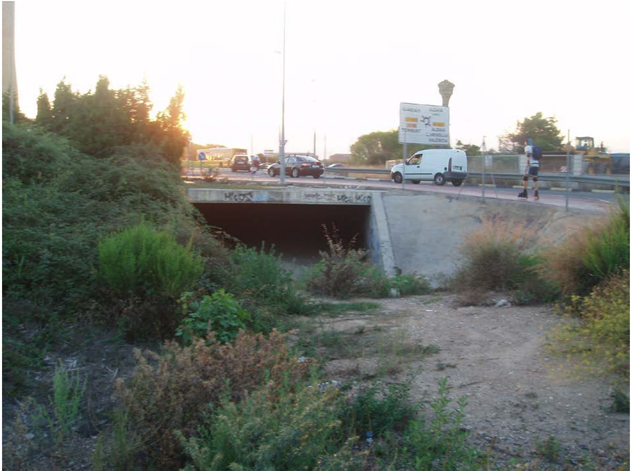
Figura 6.40 Marco de paso del barranco de La Saleta bajo la rotonda de la carretera CV- 403 entre Xirivella y Alaquàs.
