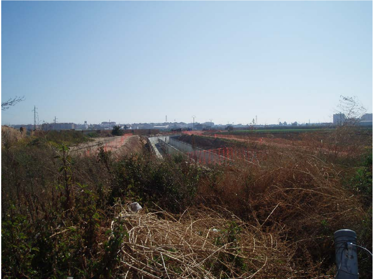
Figura 6.35 El aliviadero del colector de Hermanos Machado al Carraixet en construcción.
