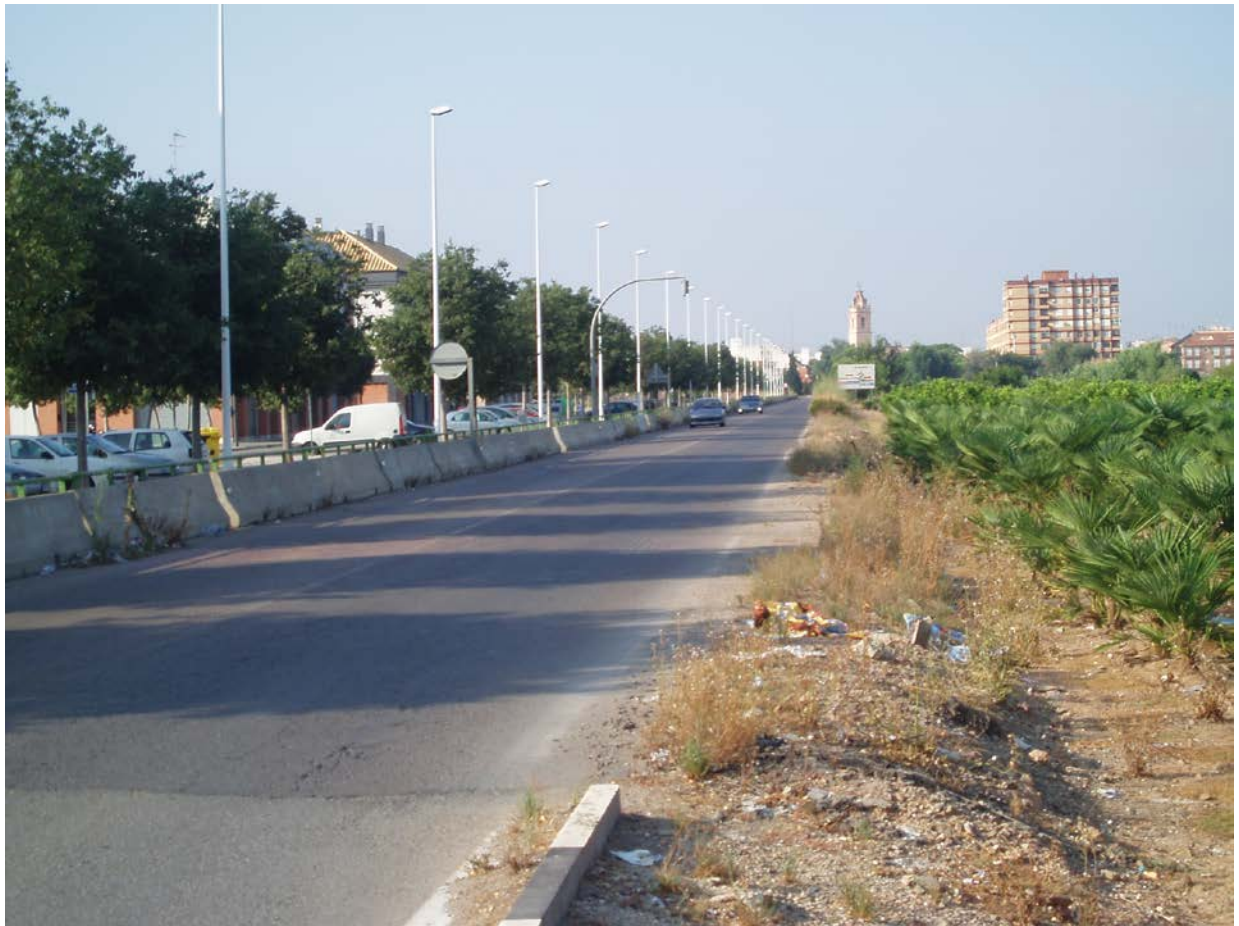
Figura 7.5 Vial que delimita la zona urbana de Massamagrell por el oeste. Al fondo Museros. Este vial forma una barrera continua al barranco.
