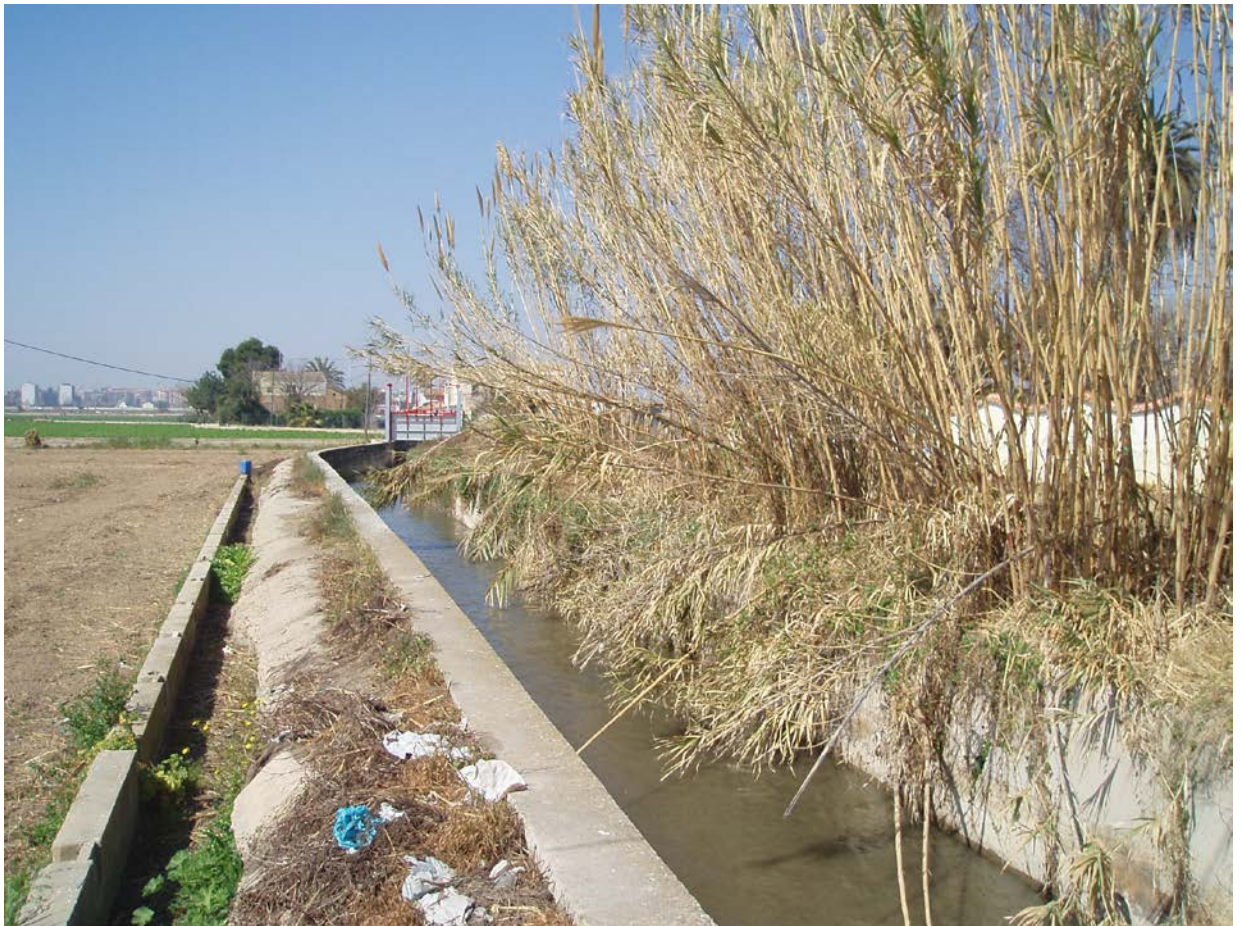
Figura 6.32 Compuerta de riego en la Acequia de Vera en las inmediaciones del Molino de Vera
