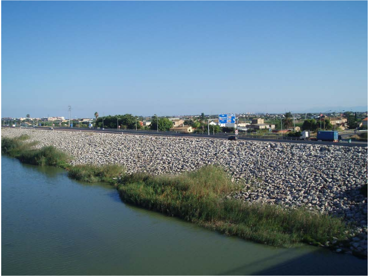
Figura 6.10 Cajeros del tramo 3 de la Solución Sur.
