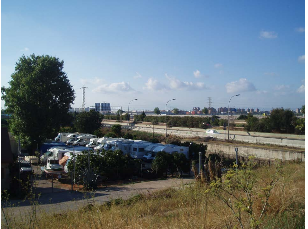
Figura 6.13 Terraplenes de la solución Sur en Castellar.
