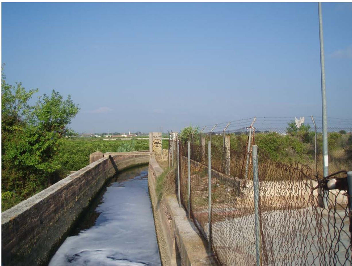
Figura 7.2 Acequia de Moncada en Massamagrell. Obsérvese cómo discurre en terraplén interceptando el flujo del barranco.
