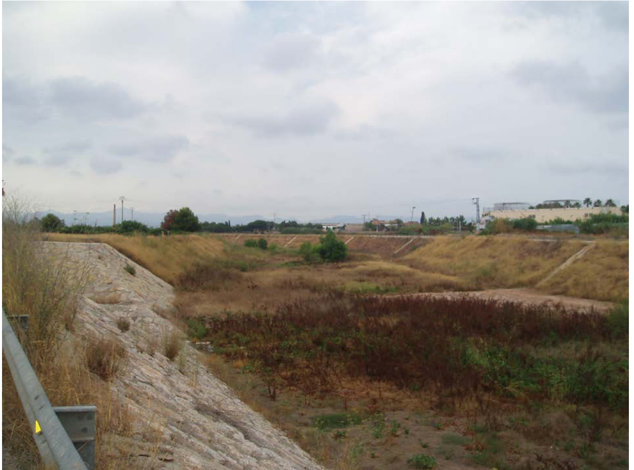
Figura 6.19 Encauzamiento del Barranco del Carraixet Tramo 2 en la confluencia del interceptor del Palmaret Alto.
