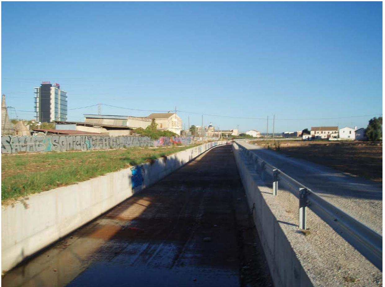
Figura 6.33 Aliviadero del Derramador de Hermanos Machado.
