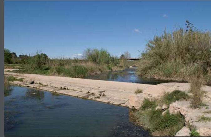
Azud sobre el río Turia para derivación del agua de riego de la huerta. Los azudes constituyen elementos patrimoniales hidráulicos de la Huerta de Valencia.
