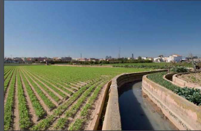
Brazo de la Acequia de Mestalla, Petra, elemento vertebrador de este paisaje de huerta. Al fondo barrera visual generada por el continuo urbanizado.
