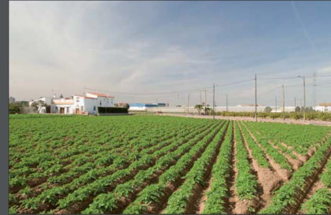
Alteración del paisaje de huerta provocada por la localización de naves industriales y por el paso de una gran cantidad de tendidos eléctricos.
