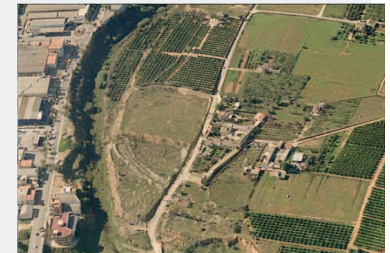
Imagen aérea en la que se muestra como el barranc de Torrent conforma a lo largo de su recorrido un elemento de contención de la urbanización sobre la Huerta
