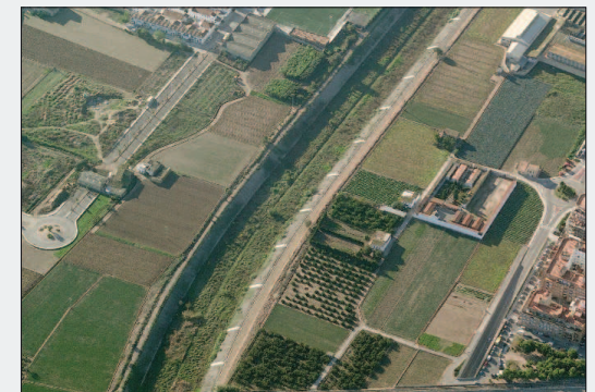
Tras las obras de revestimiento del cauce del Carraixet, este ha recuperado en buena medida la vegetación propia y con ello numerosas especies vuelven a utilizar este espacio, convirtiéndolo en un corredor ecológico de gran interés
