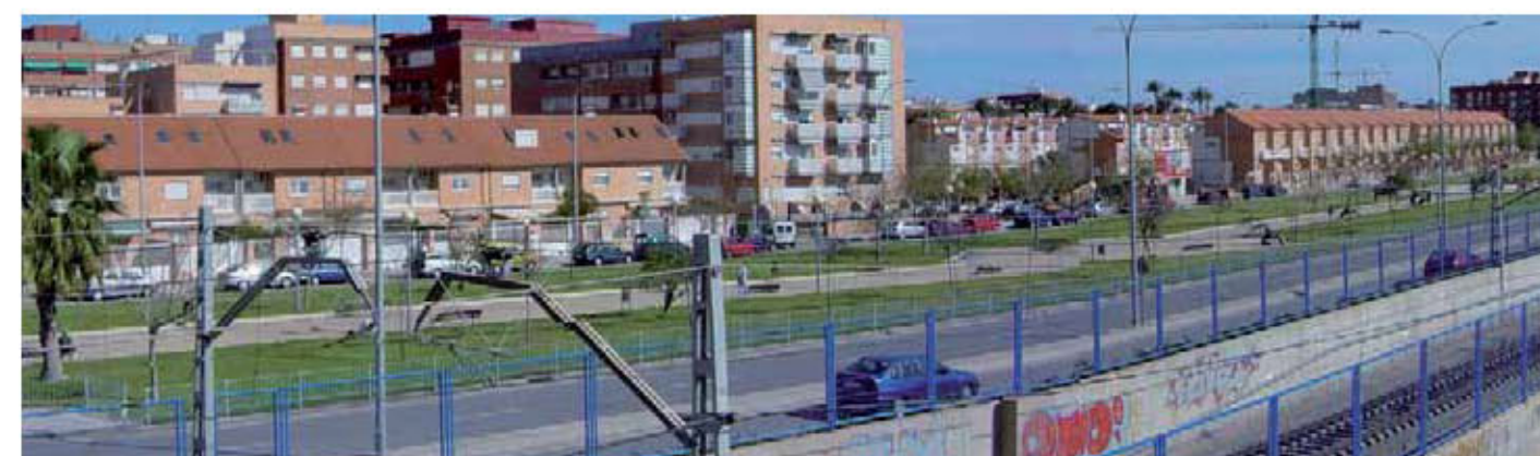
FIGURA 2.6-10: vista de la línea férrea Valencia-Barcelona en Valencia
