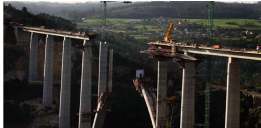
Construcción de infraestructuras de comunicación sobre el río Ulla
