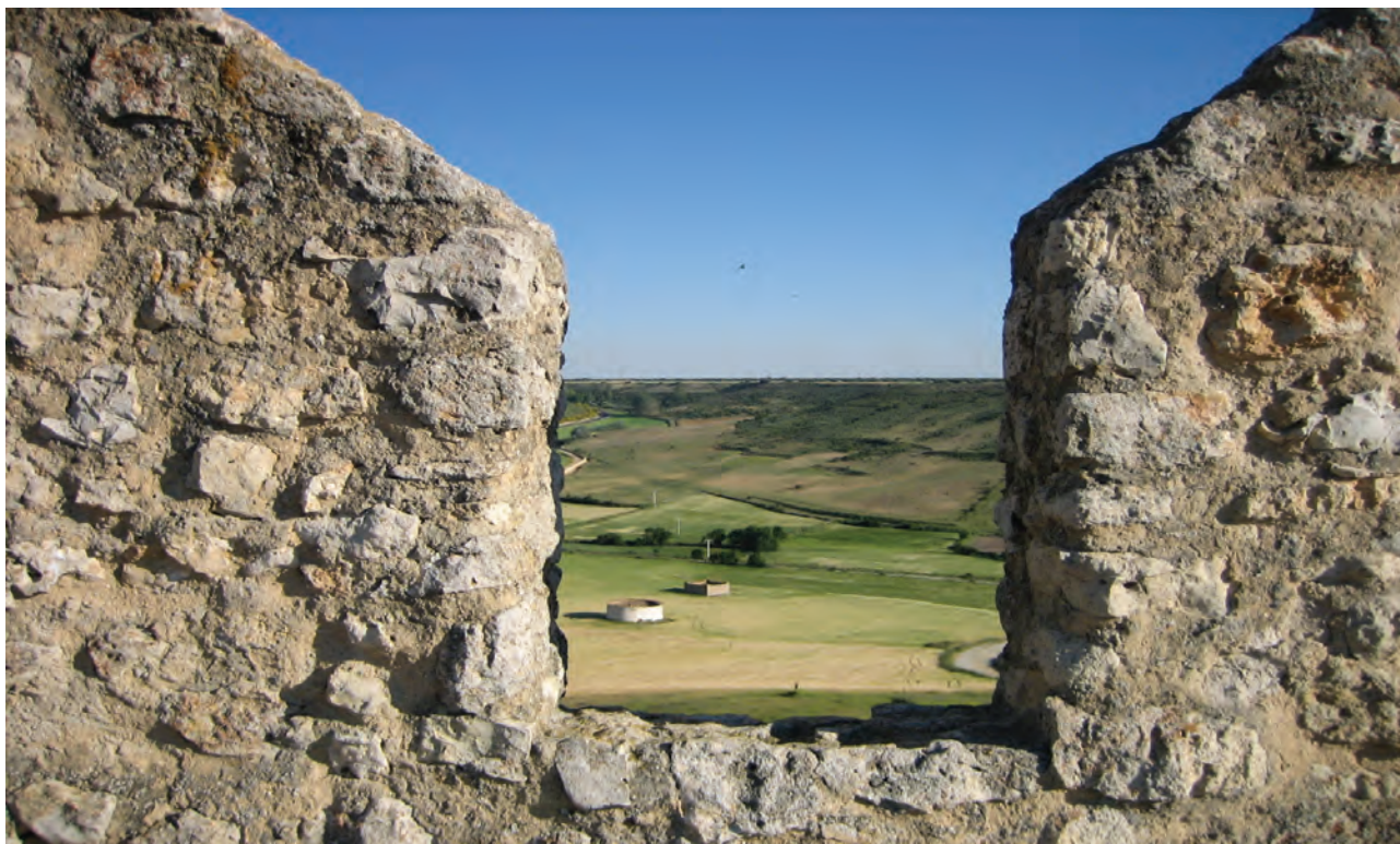
○ Figura XIX.2. Muralla de Urueña (Valladolid).
