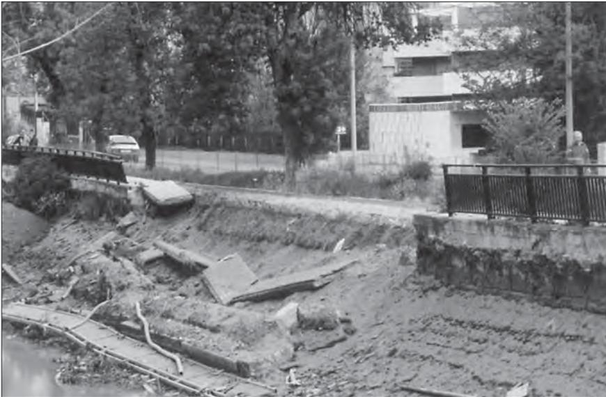
Figura 1. Hundimiento por socavación de las riberas.
