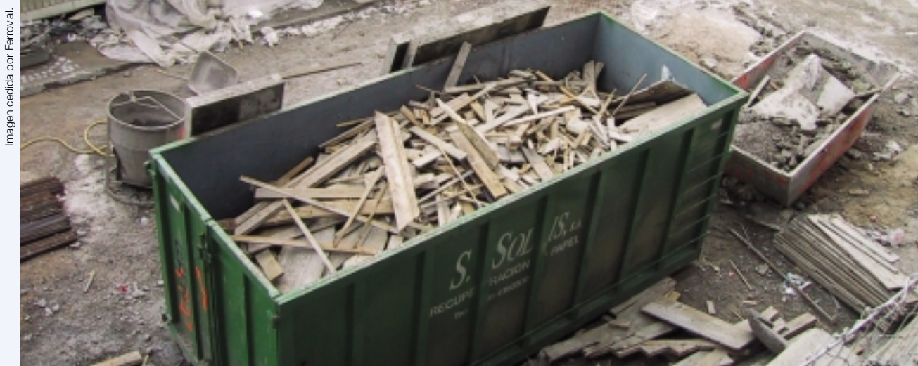
Clasificación de residuos de madera en una obra de edificación.
