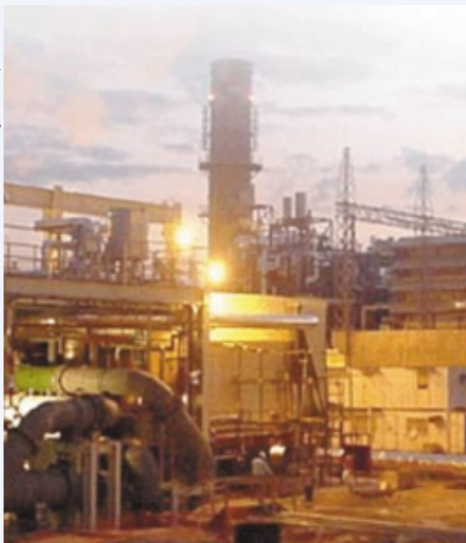
Central de ciclo combinado de Iberdrola en México.
