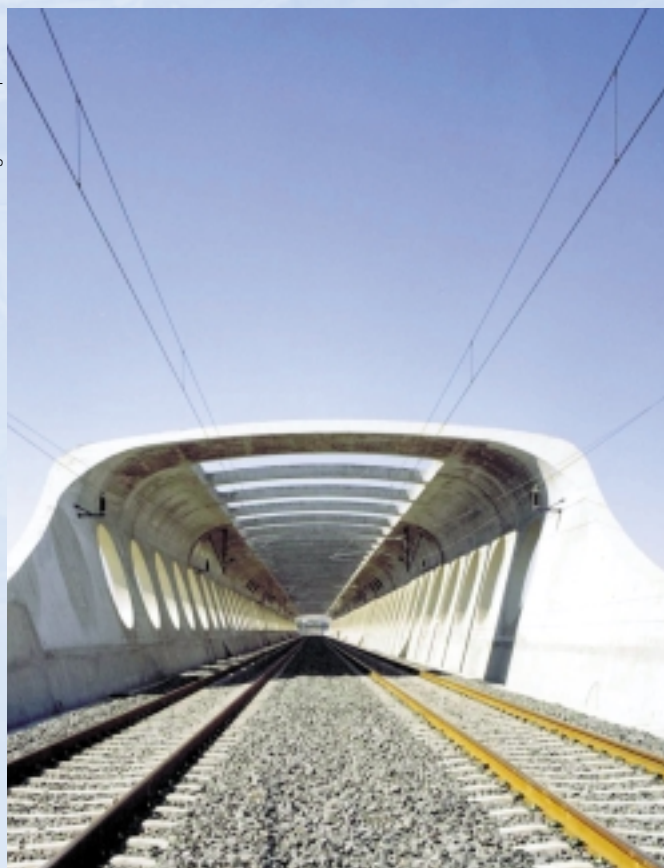
Pantalla acústica en el puente en el paso de la línea férrea por Pina de Ebro (Zaragoza).
