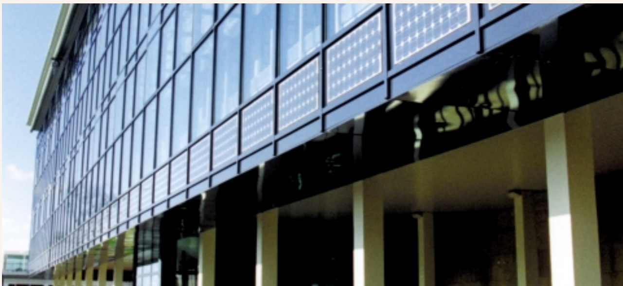
Edificio "FEUGA (STELLA)", Santiago de Compostela. Arquitectos: Emilio Miguel Mitre, José Antonio Hernando Ezquerro, Benigno Jáuregui Fernández.
