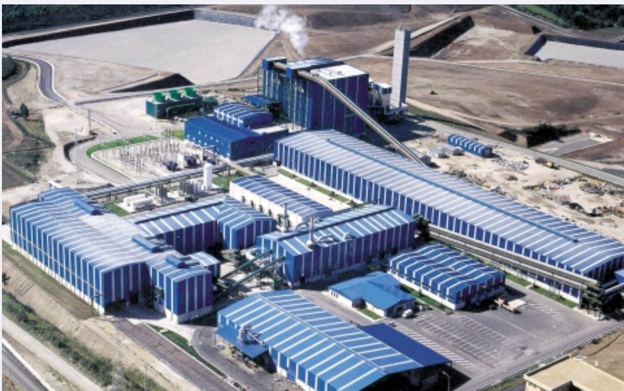
Planta de tratamiento de residuos Sogama (Galicia).
