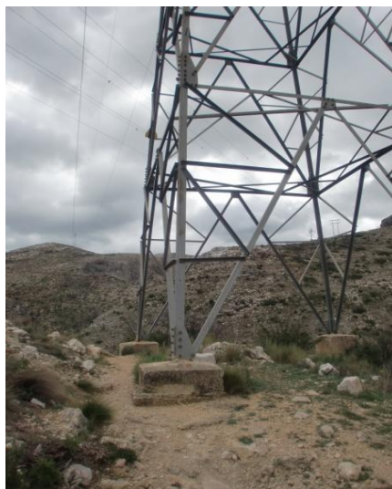
Imagen 17: Estado actual del tramo.
