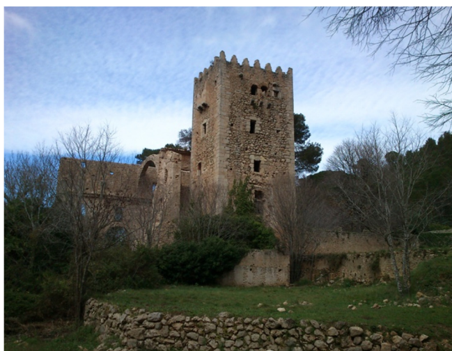
Imagen del Monasterio y la Torre dels Coloms Fuente: Elaboración propia
