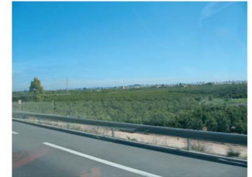
FIGURA 2.3-13: Vista desde carretera Autor: equipo redactor.
