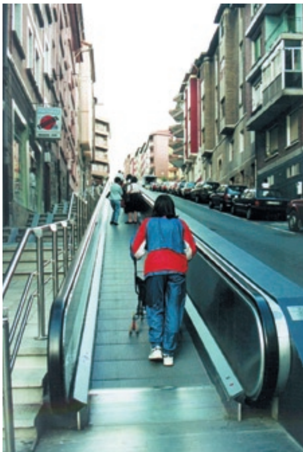
Rampas mecánicas en Basauri (Bizkaia).
