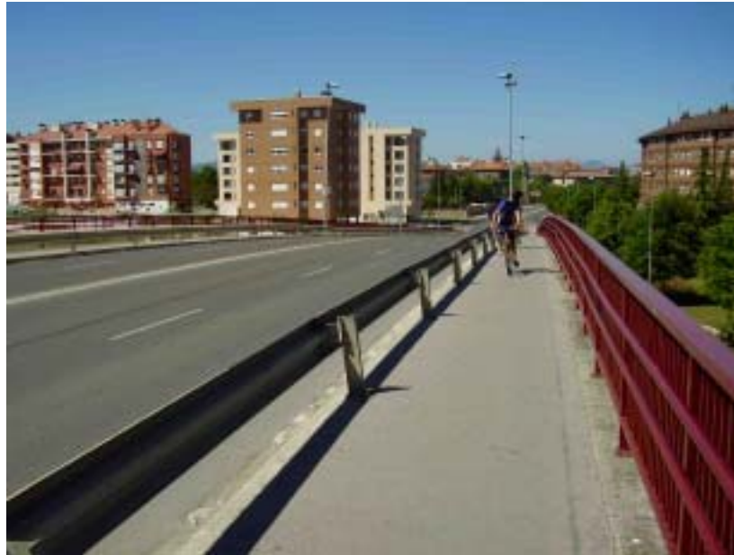
Ilustración 1. Permeabilidad diferencial del ferrocarril. Puente en el que los modos no motorizados no tienen condiciones adecuadas de paso.
