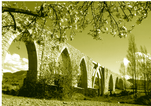
Acueducto medieval de Alpuente
