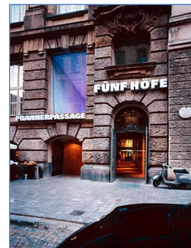
Acceso en edificio rehabilitado
