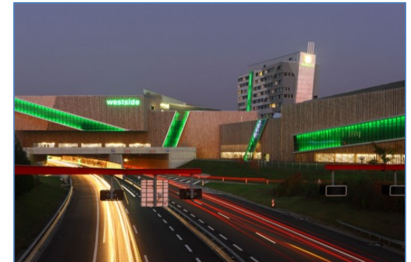
Fachada Centro Comercial Tyrol
