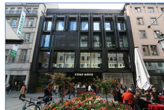
Zona nueva construcción
