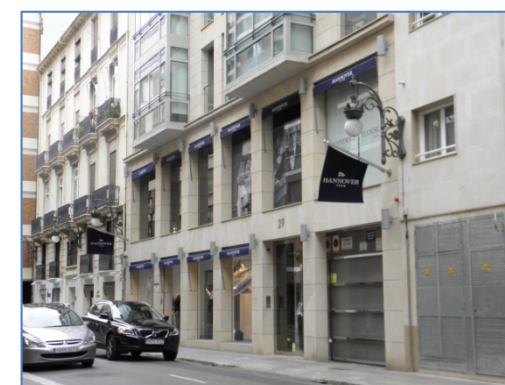
Comercio de imagen elegante en edificio de reciente construcción: materiales y composición similares
