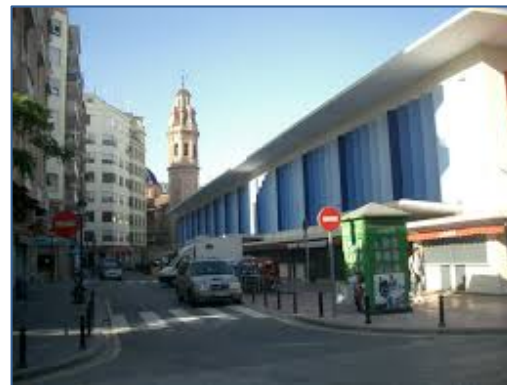
Intervención reciente en el Mercado de Ruzafa en Valencia
