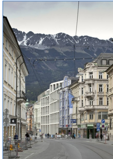
Fachada Centro Comercial Tyrol
