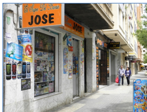
La abundancia de elementos en esta fachada comercial se extiende del escaparate a las fachadas del edificio creando una mala imagen.
