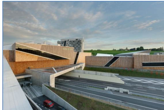
Fachada Centro Comercial Tyrol
