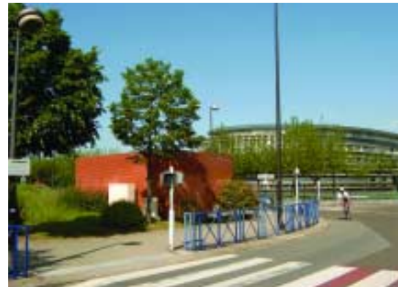
Les estacions transformadores aïllades han de tenir un tractament específic i en relació amb les característiques de l'entorn on són ubicades.
