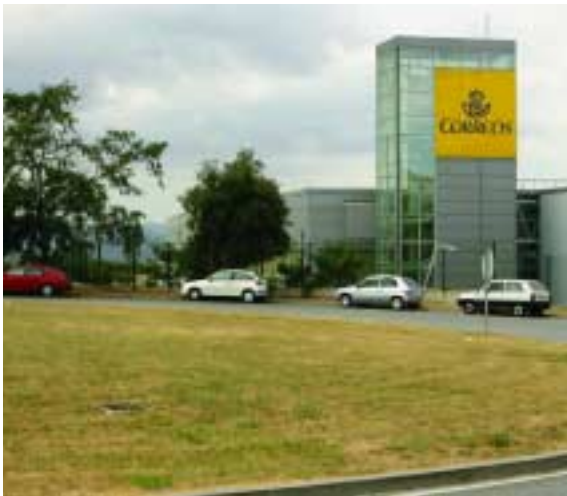
La publicitat i la senyalètica han de tractar-se com a part dels components de l'edificació.
