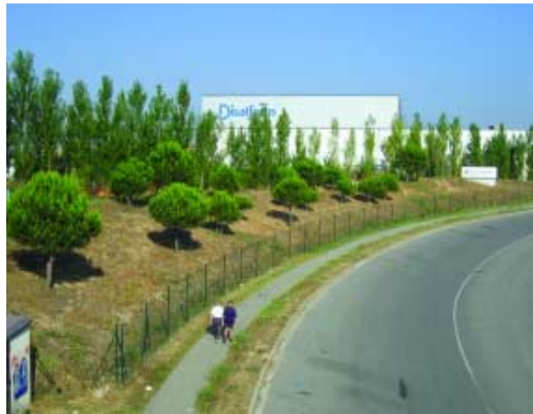
La reserva d'espai suficient a les vores dels vials és una exigència per tal de crear talussos aptes per a ser revegetats.
