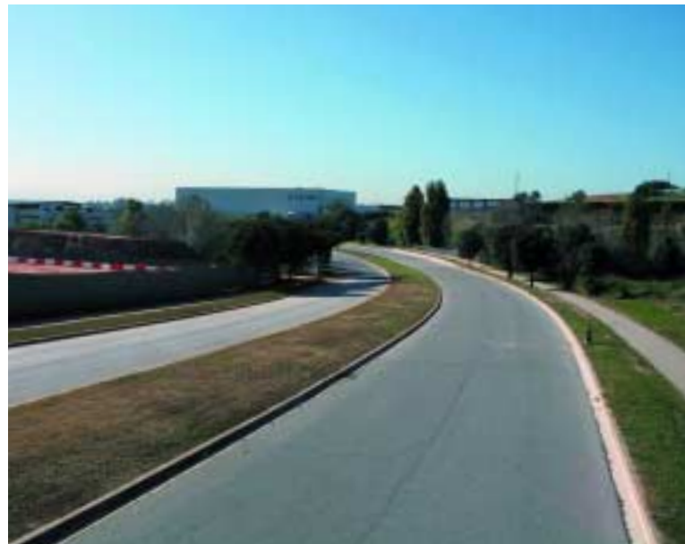
L'adaptació de la trama dels vials a la morfologia dels llocs és fonamental. Els traçats sinuosos, que ressegueixen la forma del relleu i permeten descobrir una seqüència d'imatges de l'entorn, poden ser la millor opció segons les característiques de l'emplaçament.
