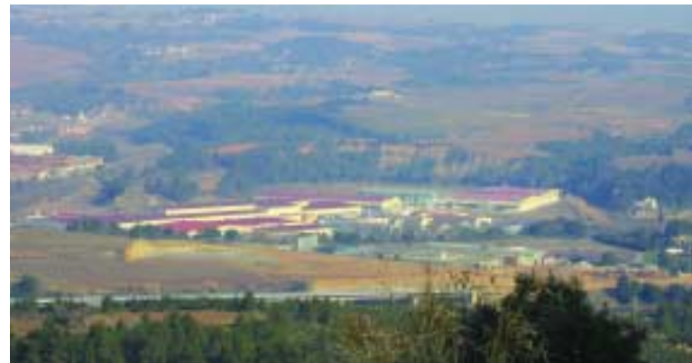
A causa de les seves superfícies, les cobertes de les edificacions esdevenen sovint elements molt visibles.
