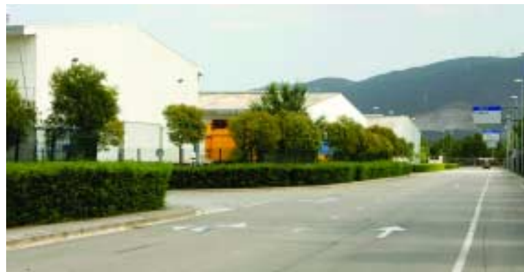
La regularitat volumètrica de les edificacions contribueix a la creació d'una imatge unitària i coherent dels espais industrials.
