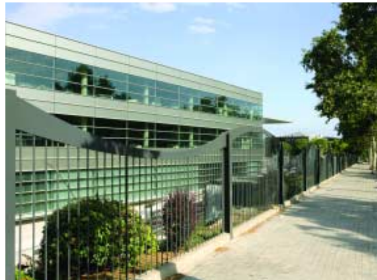
Les tanques amb un disseny singular tendeixen a ressaltar la parcel·la que ocupen respecte a les del voltant. Cal valorar la transparència, la simplicitat, l'adaptació al pendent i la discreció d'aquesta tanca.
