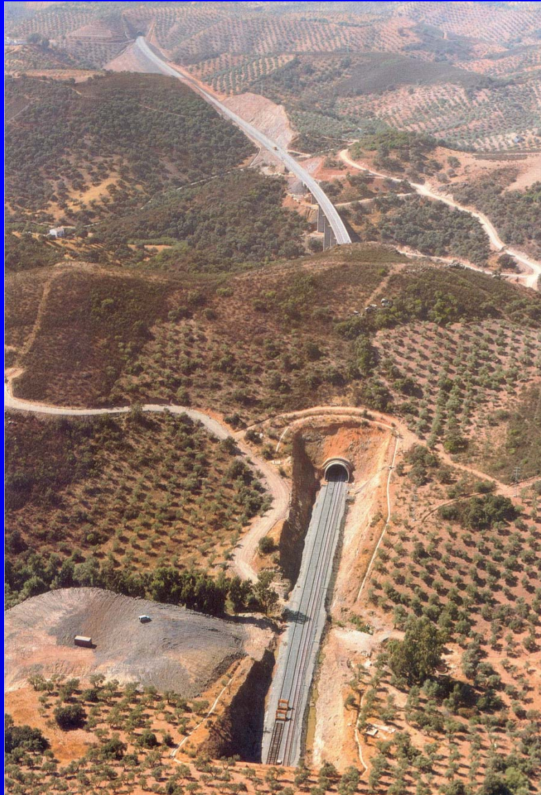
P.K. 309,6 Vista hacia el sur. Encima de la boquilla sur del túnel del Acebuchoso y norte del Piedras del Aire. A continuación Viaducto de La Parrilla. Al fondo boquilla norte del túnel del Cortijo
