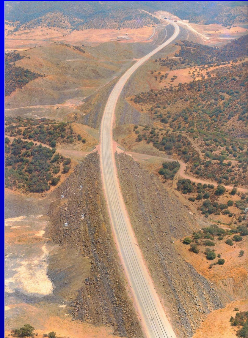
P.K. 324,1. Vista hacia el norte. Terraplenes entre los PK. 321,2 y 324,2. Al fondo boca sur del túnel Lomas del Partidor
