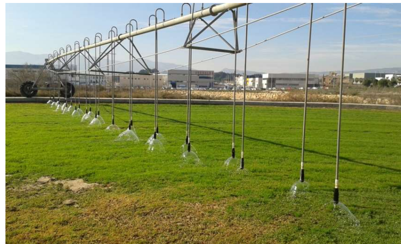
EDAR Valle del Vinalopó. Infiltración - percolación
