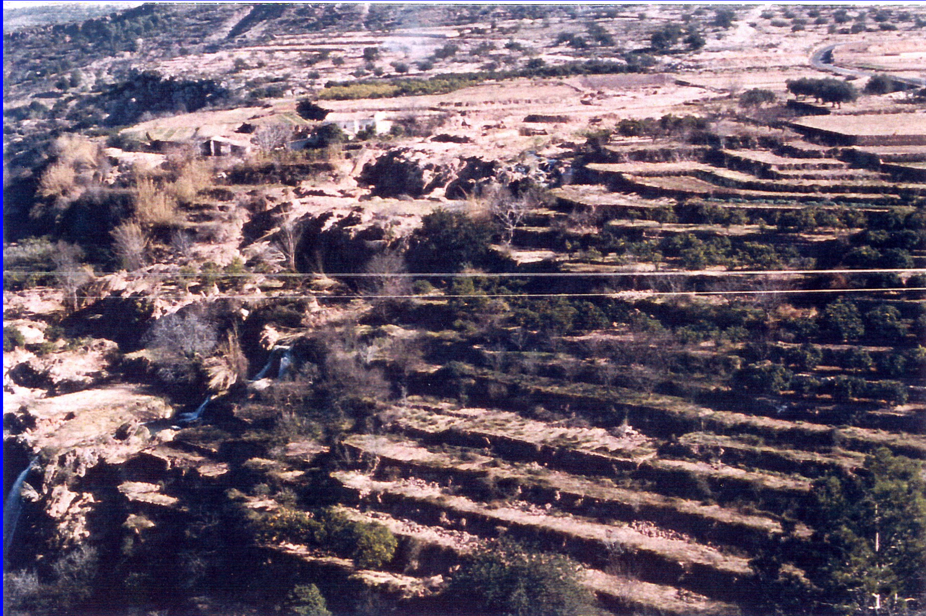
Rotura de bancales como consecuencia de la riada de 1982 (Navarrés, Valencia)
