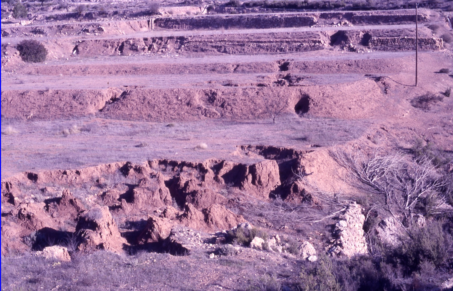
Erosión en tunel en terrazas con talud de tierra (Cofrentes, Valencia)
