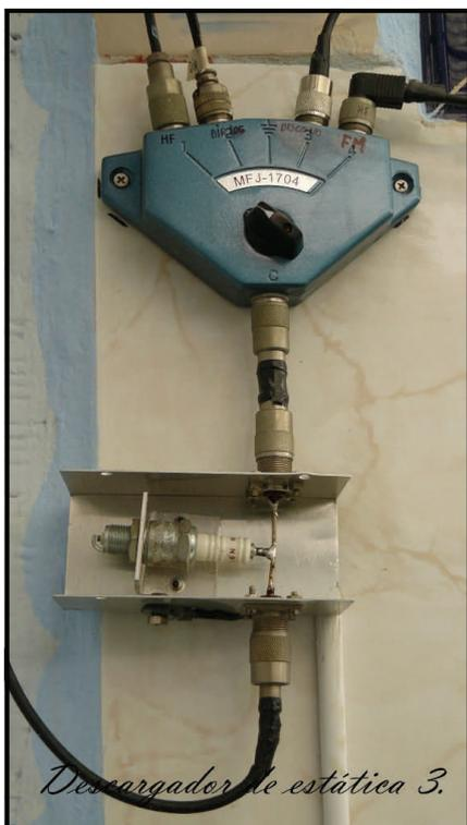
Fotografía del descargador montado en la bajante de la antena
